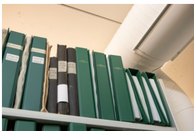
Kuva 9. Säilytystilan katossa kulkeva putki vähentää hyllytilan korkeutta. (Oja 2022.)
