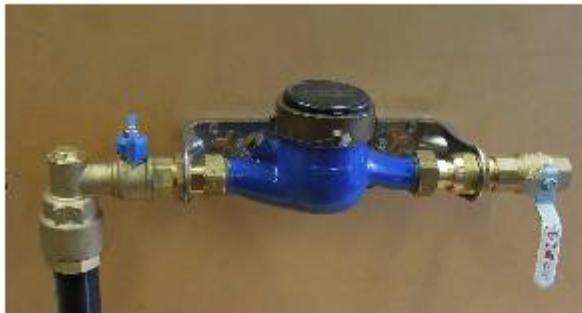
Kuvassa tyypillinen omakotitalon vesimittari (DN 20) telineessä
