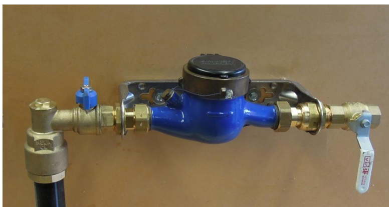
KUVA 1. Omakotitaloissa tyypillisesti käytetty siipipyörämittari
