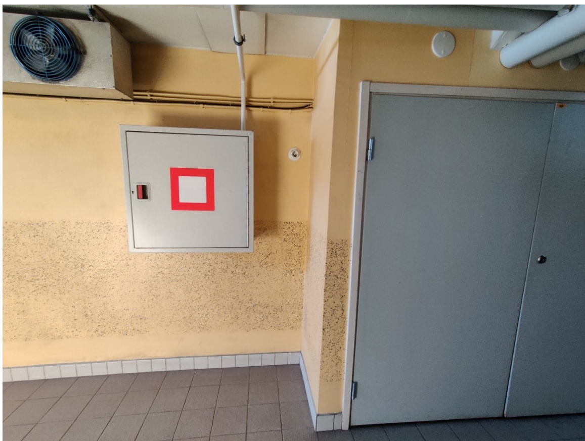
Kuva 11 Kaapelin läpivienti keskushuoneesta 2/2 (Luukkonen, 2022)
