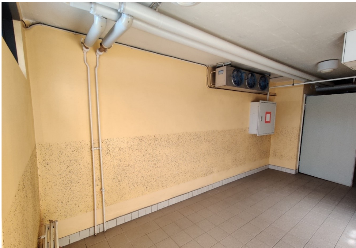
Kuva 12 Kaapelireitti sisällä (Luukkonen, 2022)
