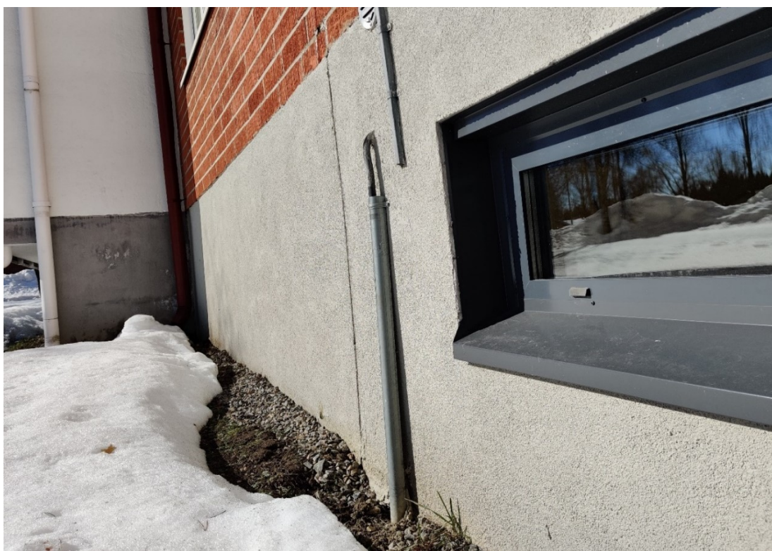
Kuva 13 Kaapelin läpivienti ulos (Luukkonen, 2022)
