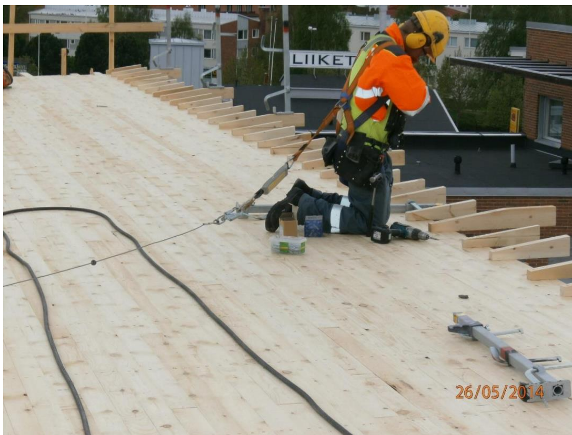
KUVA 23. Kaiteiden asennusta räystäälle. (Koskela 2014, 23)
