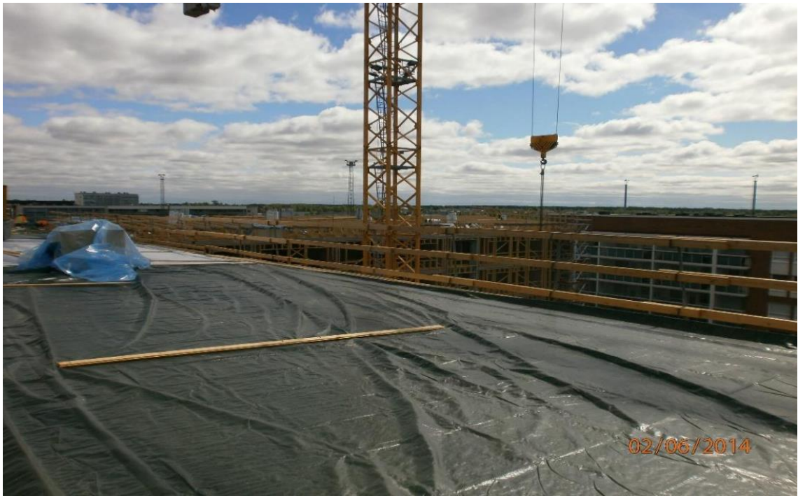
KUVA 21. Naulalevyristikoilla toteutettavan pukkikaton työnaikainen suojaus (Koskela 2014 ,25)
