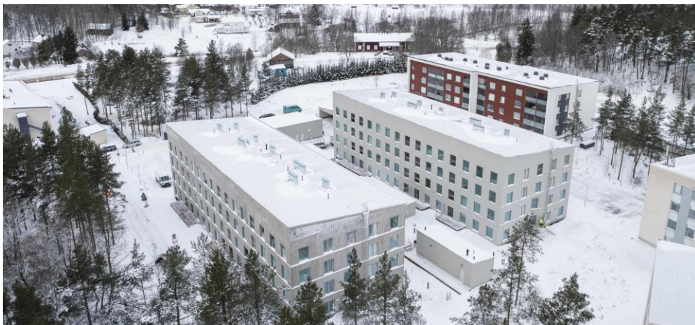
KUVA 1. Puu- ja betonirunkoinen asuinkerrostalo Turun Hirvensalossa. (Mangrove Oy 2022)
