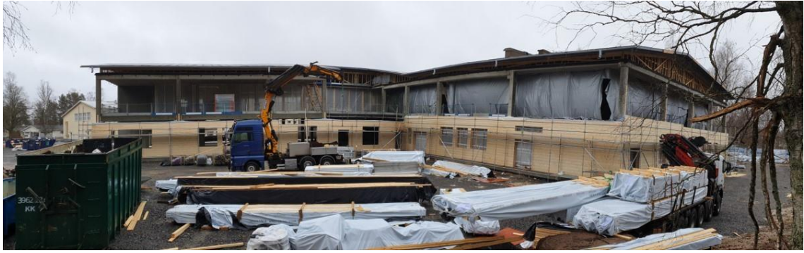
KUVA 22. Virtain yhtenäiskoulun kattoelementit asennettuna ja ulkoseinätyöt aloitettuna. (Virtain kaupunki 2019)
