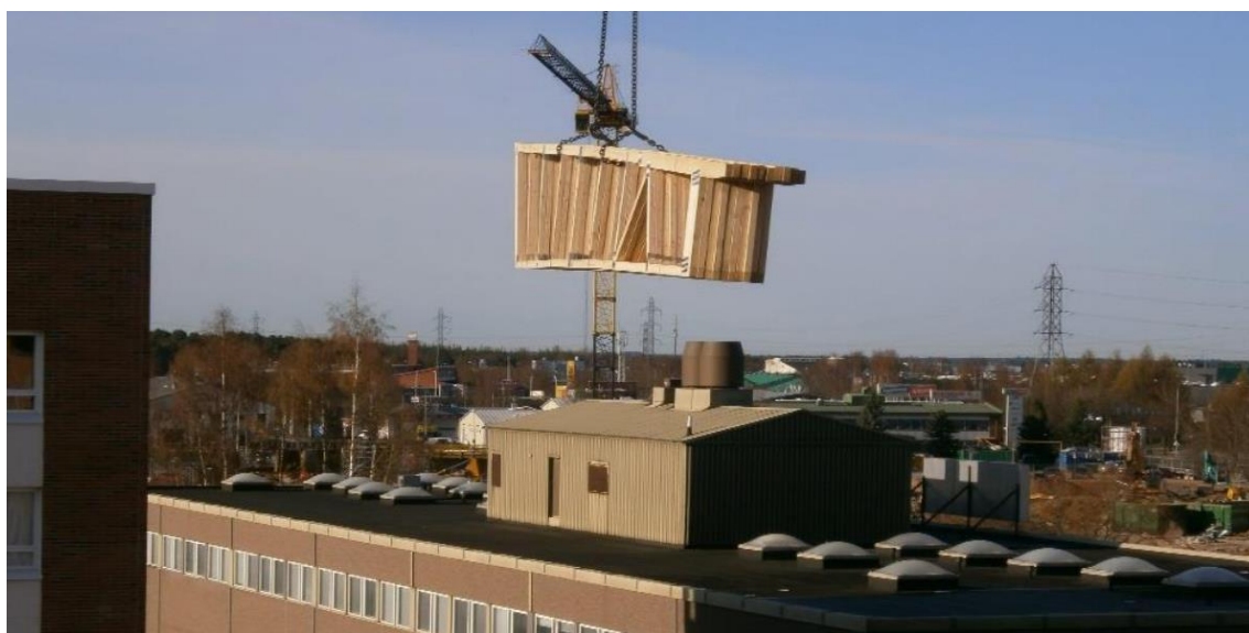
KUVA 5. Ristikkonipun nosto holville. (Koskela 2014, 10)
