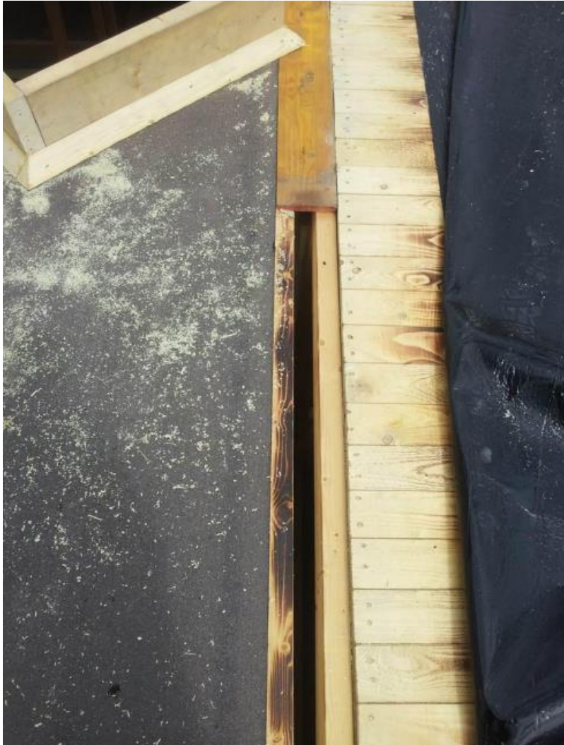
KUVA 15. Vaneritäytteen asennus kattolohkojen saumaan. (Heikkilä 2012)
