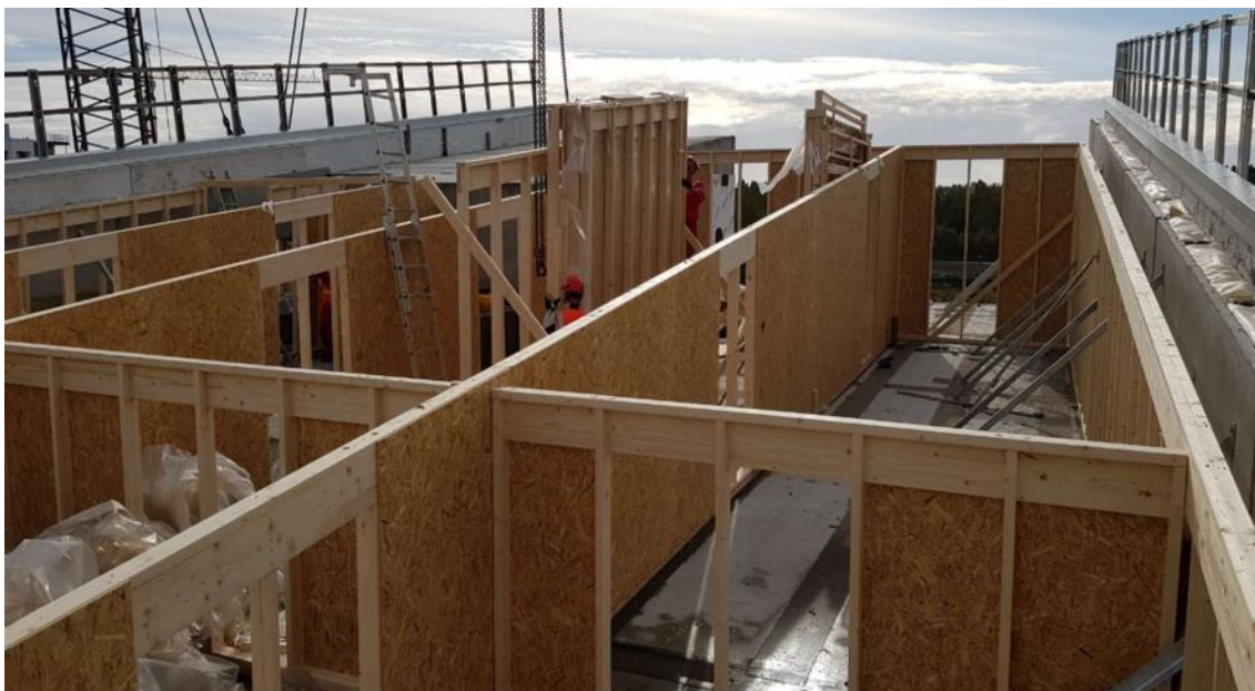
KUVA 10. Kattoelementin tukiseinät lähes valmiina. (Salopelto 2019)
