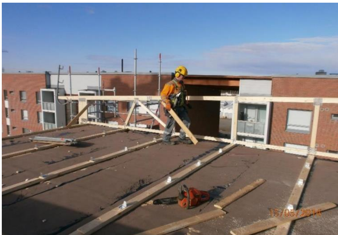
KUVA 6. Ensimmäisen ristikon asennus. (Koskela 2014, 11)
