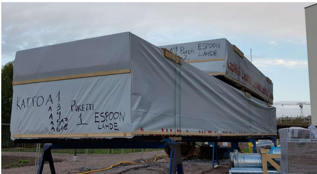
KUVA 28. Vesikattoelementit varastoituna pukkien päälle. (Salopelto 2019, 18)
