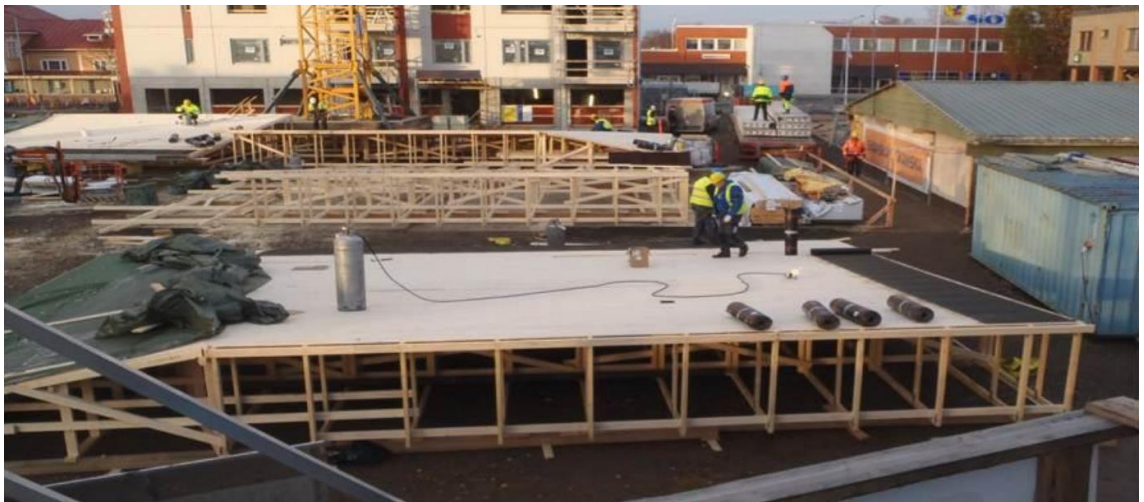
KUVA 24. Kattolohkoja maassa, kokoamisalusta toisena edestä. (Heikkilä 2012, 22)
