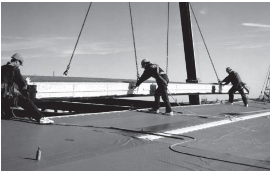
KUVA 11. Kattoelementin asennus käynnissä. (Kilpeläinen, M., Ukonmaanaho, A. & Kivimäki, M. 2001)
