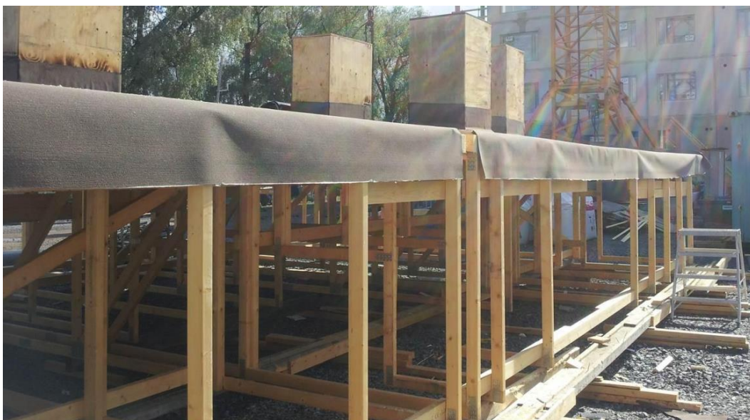
KUVA 12. Kattolohkojen saumoihin jätetty bitumihuovan liitosvarat lohkojen yhteenliittämistä helpottamaan. (Heikkilä 2012)
