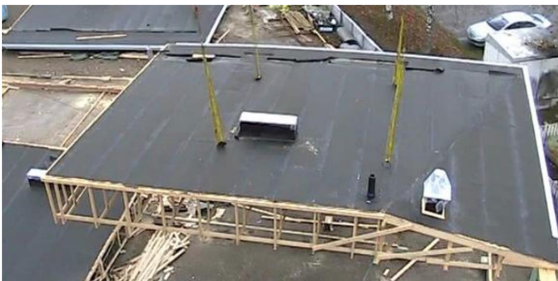
KUVA 13. Ulkojiirillinen vesikattolohko, jossa pohjakermi asennettuna. (Heikkilä 2012, 7)
