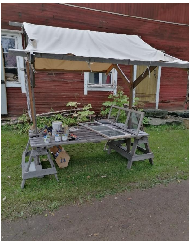
Kuva 1. Rakennuskulttuuritalo Toivon korjausneuvontakohteessa ikkunan korjausta.
