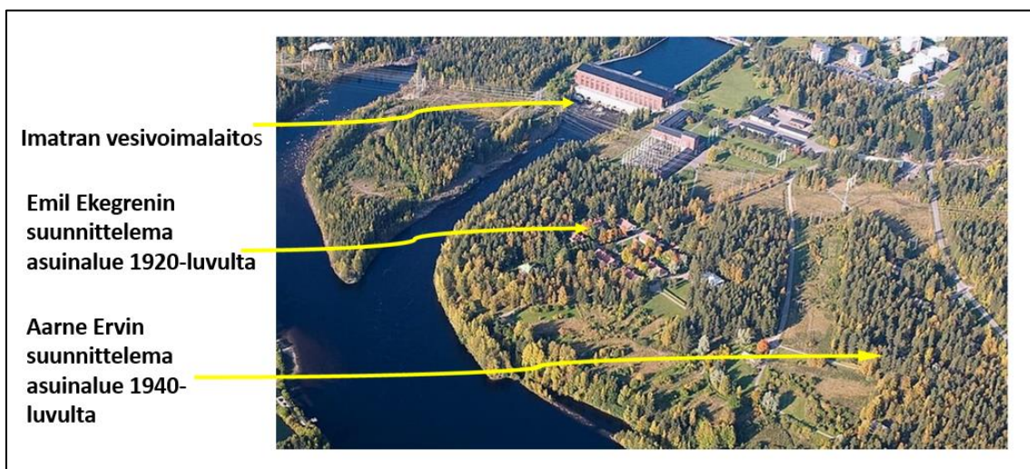
KUVA 1. Imatran vesivoimalaitos ja sen vanha asuinalue (mukaillen 4)
