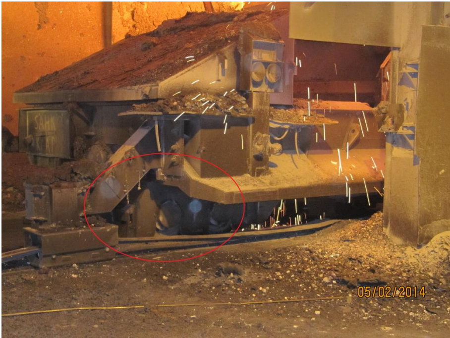
KUVA 35. Terässenkkaavun suojaamaton kohta
