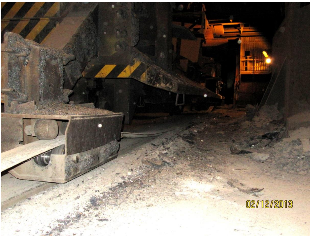
KUVA 30. Koteloinnin nostama suojalatta
