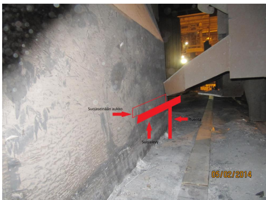
KUVA 33. Hahmotelma suojalevystä ja suojaseinän aukosta
