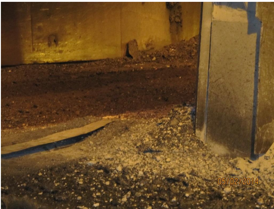
KUVA 31. Suojalatan alle ja seinän viereen kertyneitä roiskeita
