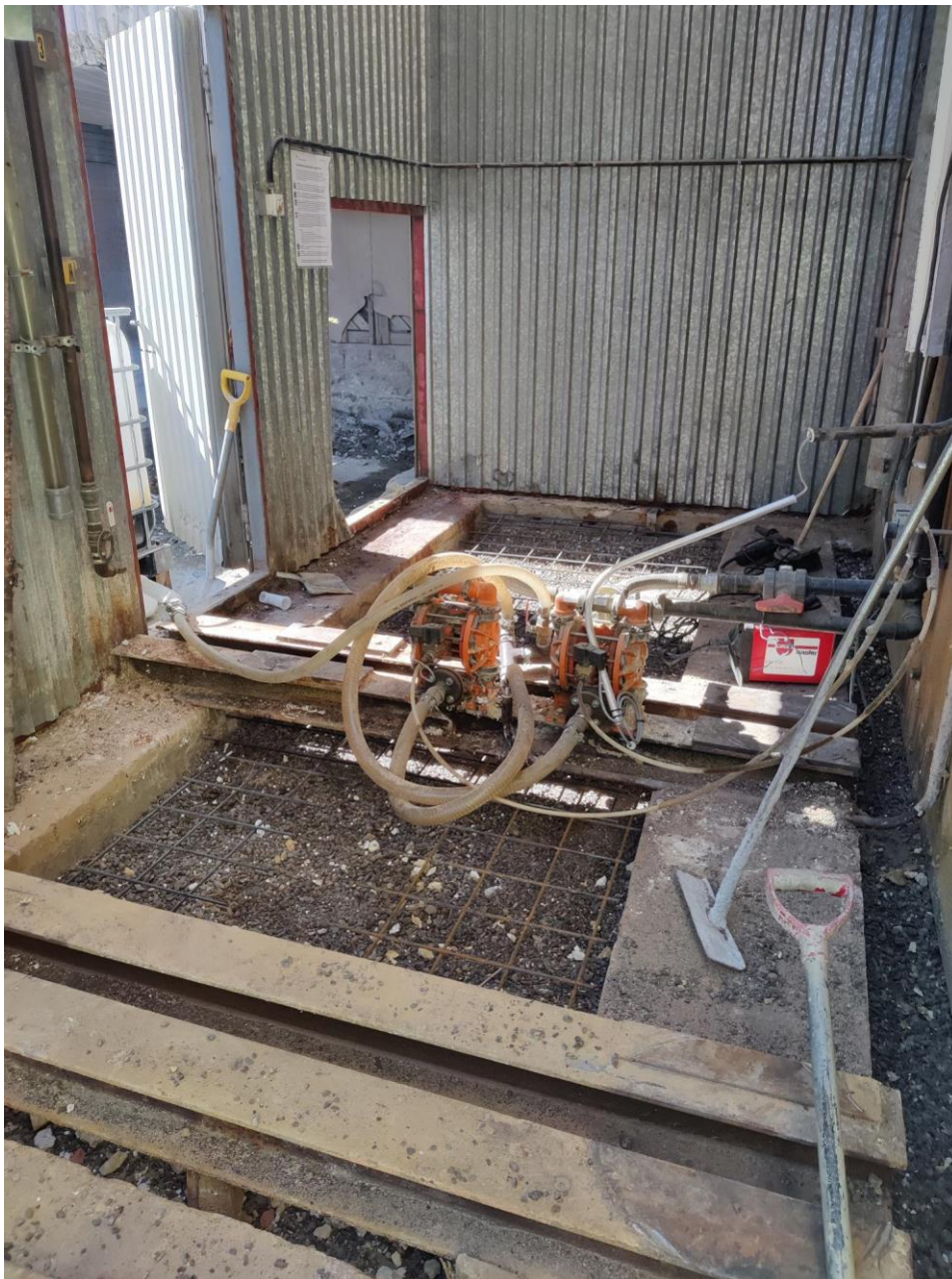
Kuva 7. Betonilaatan raudoitus
