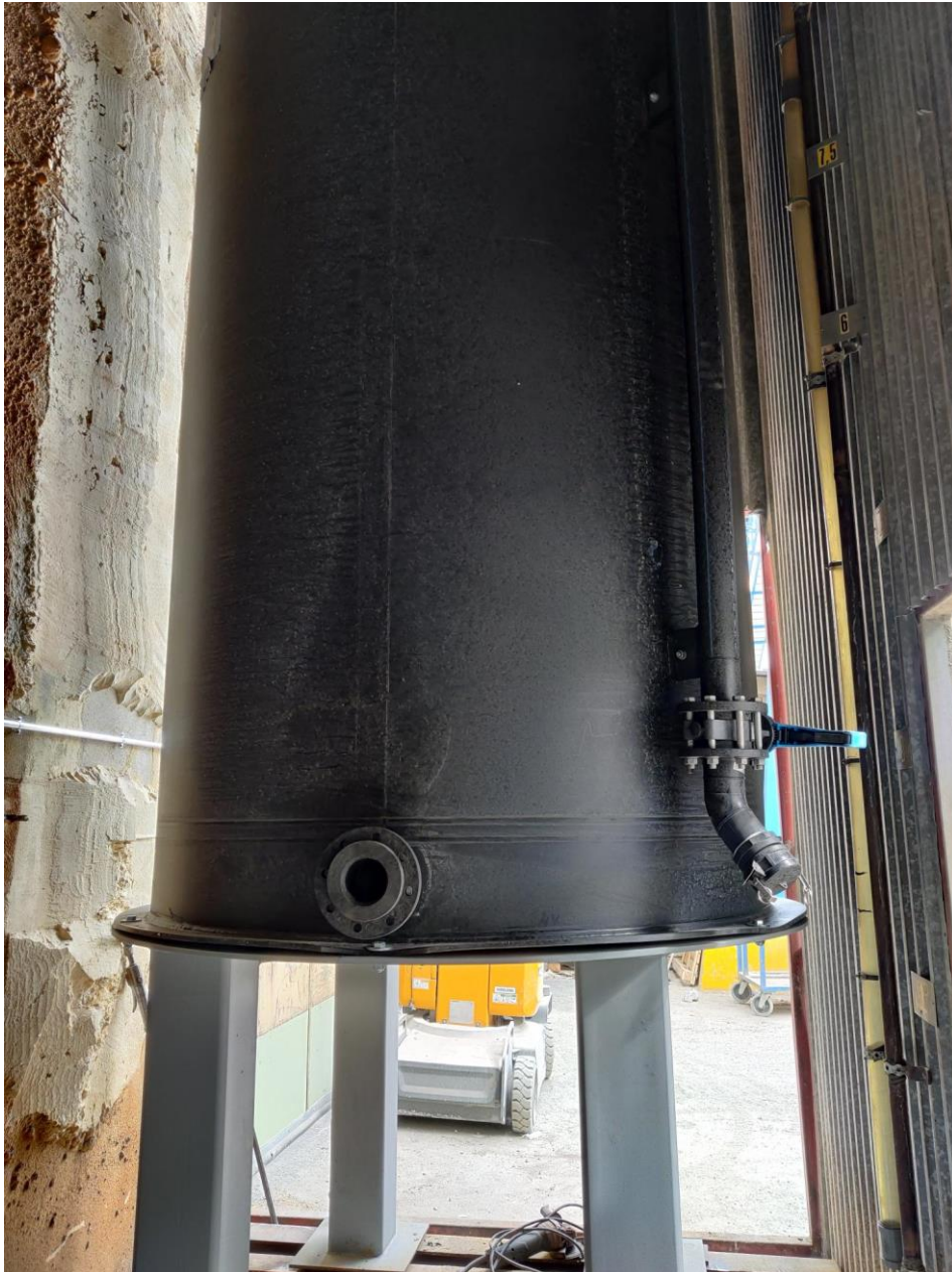
Kuva 9. Lisäainesilo kiinnitettynä paikoilleen
