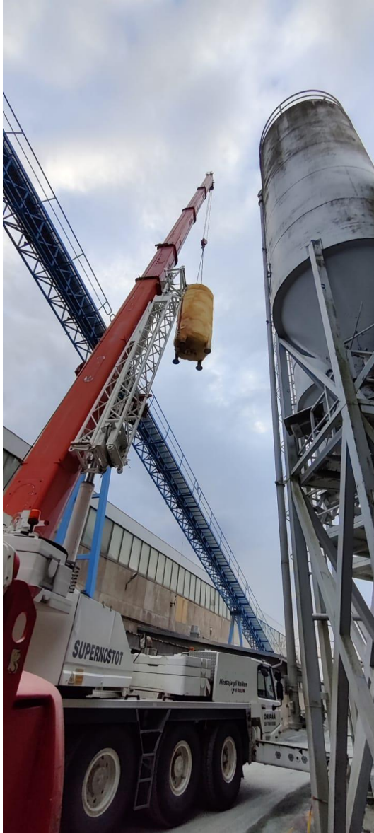
Kuva 6. Säiliön nostotyö
