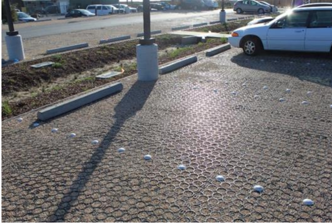
Kuva 2. Permeable Pavers tuotetta käytettynä parkkipaikalla Kaliforniassa. (TRUEGRID)
