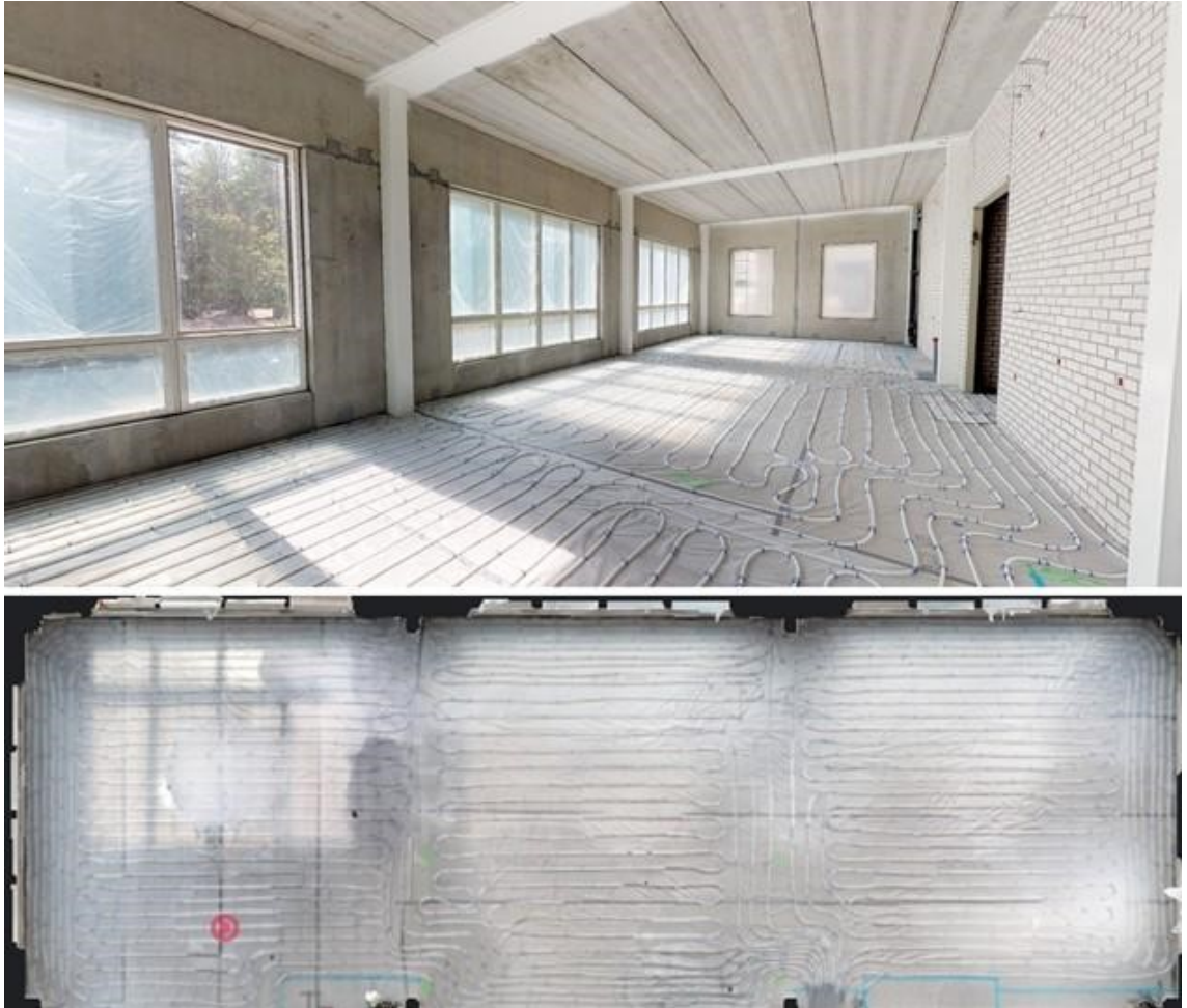
Kuva 7. Matterport-kameralla tuotettu kuva lattialämmityspotkien asennuksen jälkeen (Geotrim 2022c)
