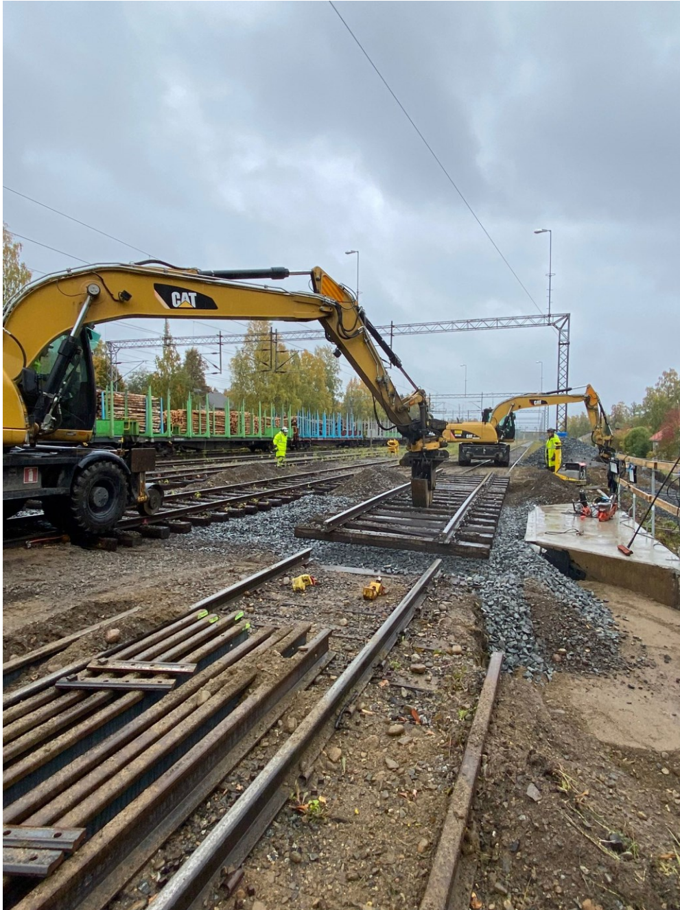
Kuva 1. Alikulkusillan vesieristyksen uusiminen työraossa (Kuva: Jaakko Kauppinen).
