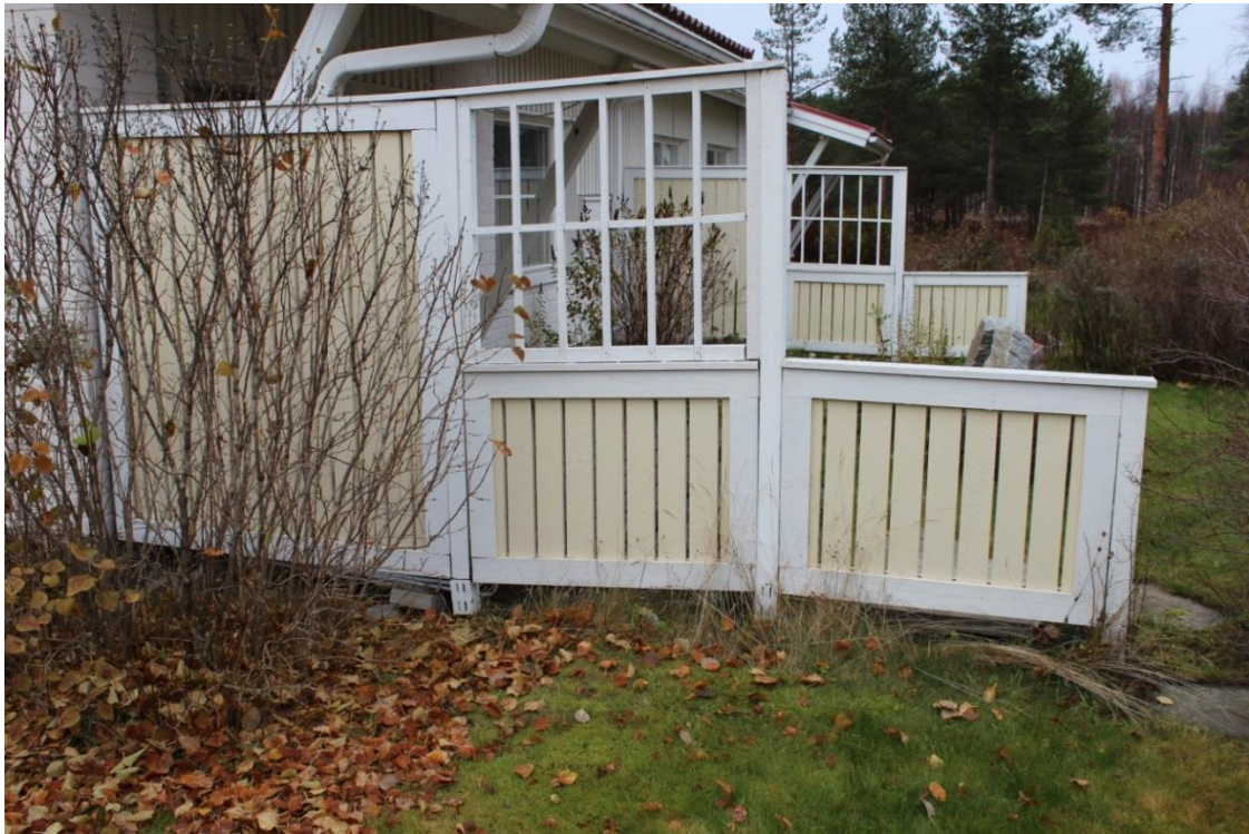
Routa nostelee aita- ja terassirakenteita
