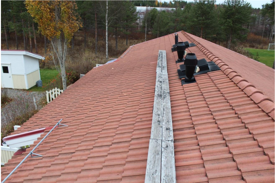
Tiilikatot ovat pääsääntöisesti hyvässä kunnossa
