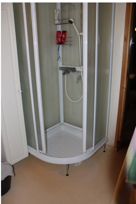
Alkuperäisiä kylpyhuonerakenteita, tila on varustettu poikkeuksellisesti suihkukaapilla
