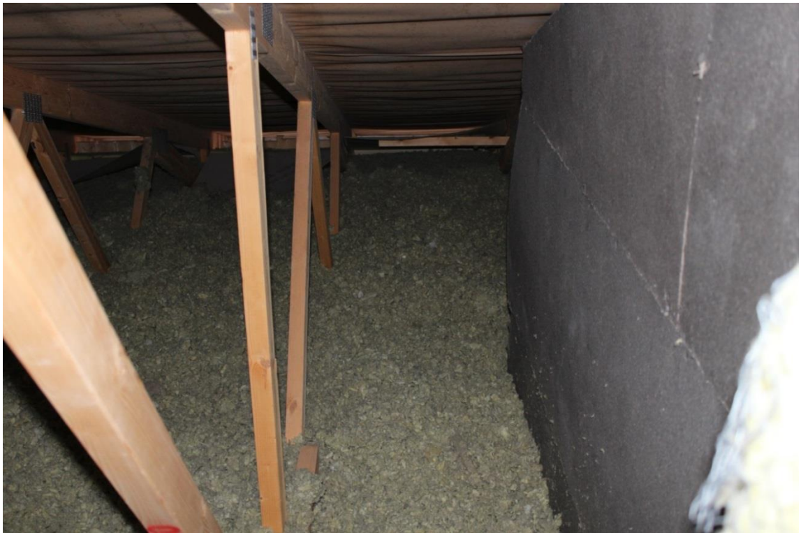
A4-huoneiston käyttöullakko on rakennettu asiallisesti
