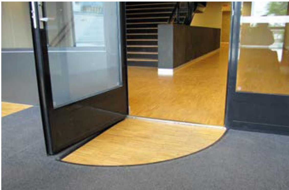
KUVA 20. Kulkijaa kohden avautuvan oven kääntösäde voidaan erottaa lattiasta materiaali- ja väri-contrastina (Esteetön rakennus ja ympäristö, Kilpelä 2019)
