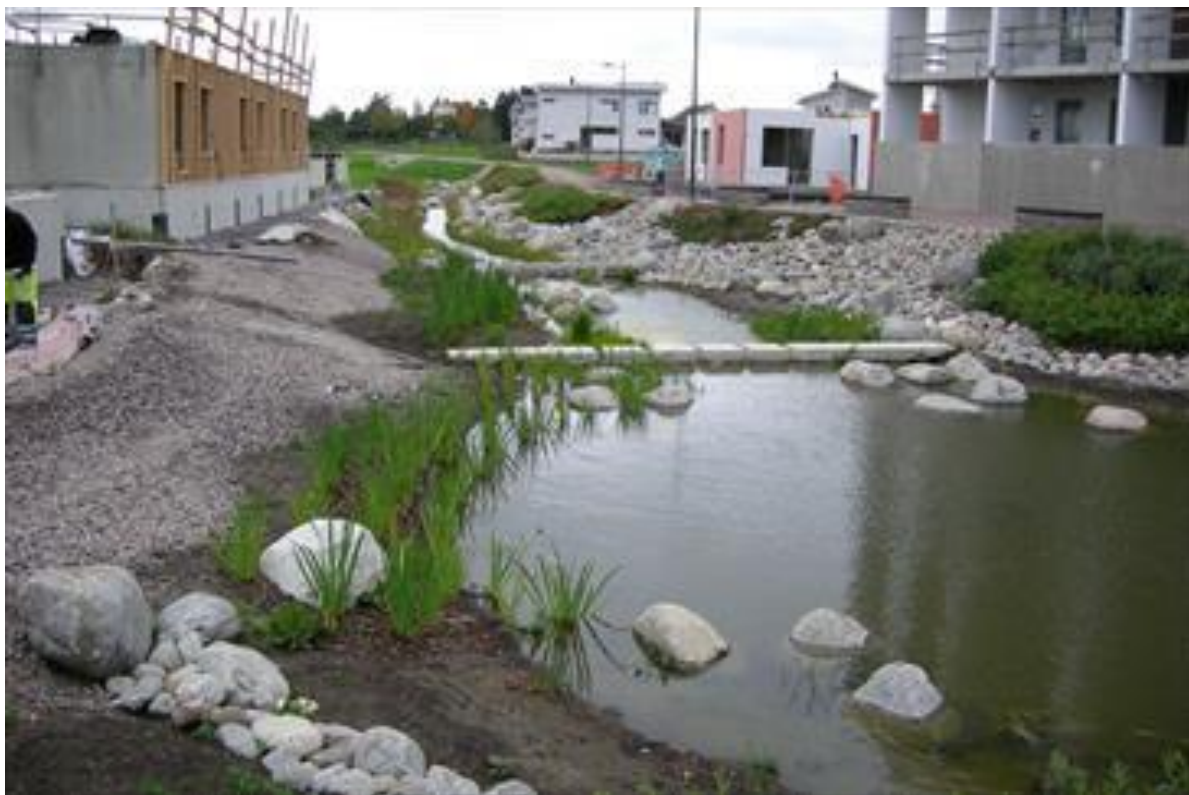
KUVA 1. Kosteikko on yksi hulevesiä viivyttävistä rakenteista (Kasvio. Julkaisuaika tuntematon)
