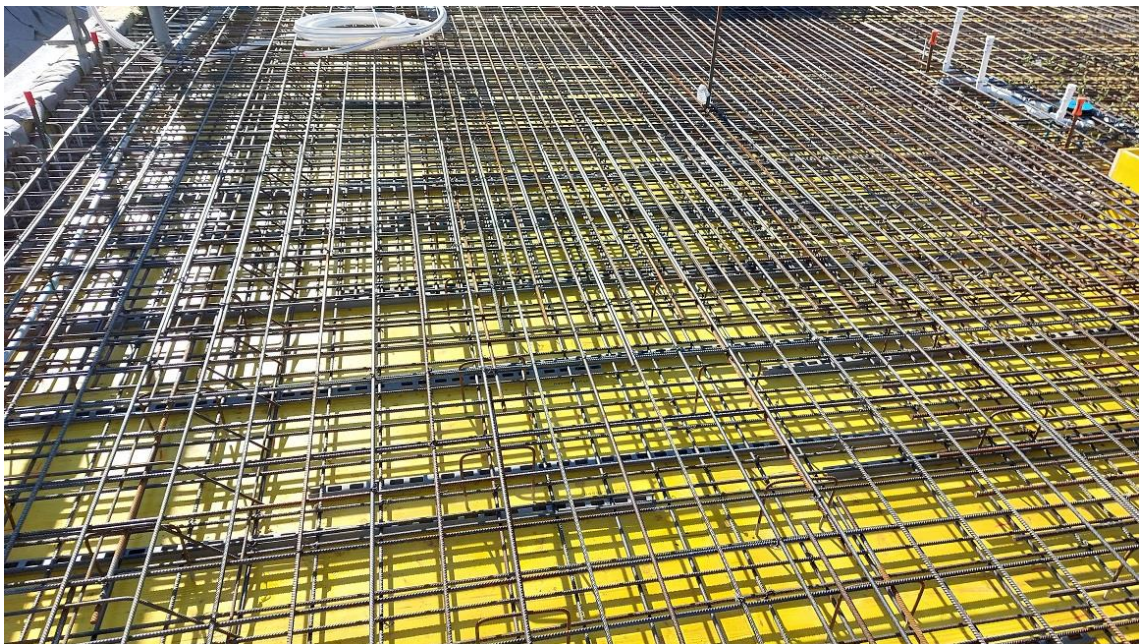
Kuva 4. Paikallavaluholvin valmis raudoitus
