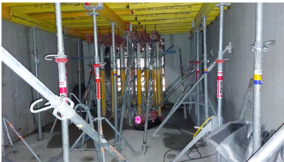
Kuva 8. Pieni polttoöljyllä toimiva lämmitin
