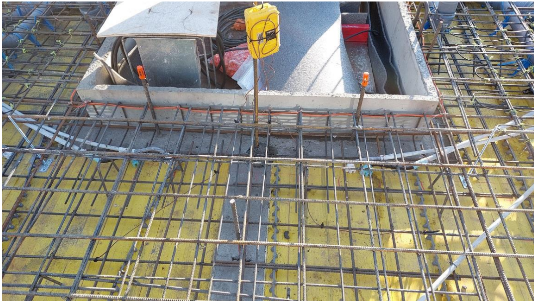
Kuva 7. Dataloggeri ja anturit hissikuilun vieressä.
