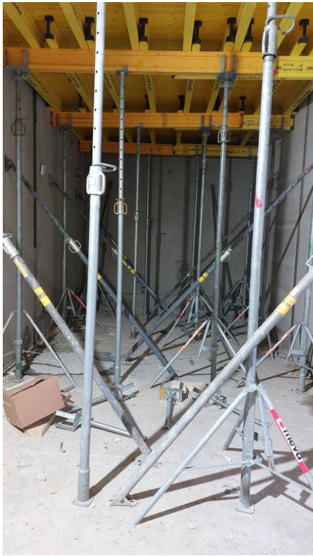
Kuva 1. Puupalkkimuotti alhaalta kuvattuna
