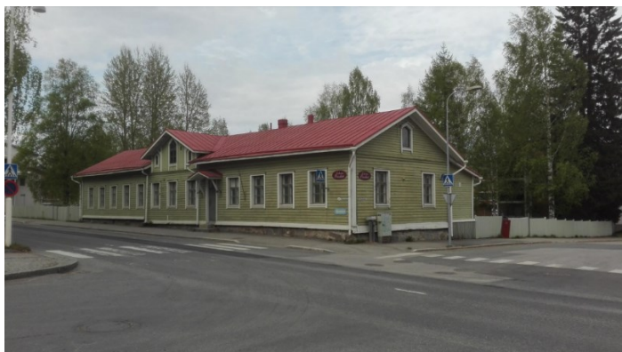
KUVA 5. Julkisivu Pohjolankadun ja Päiviönkadun risteyksestä. (Iisalmen kaupunki 2019)
