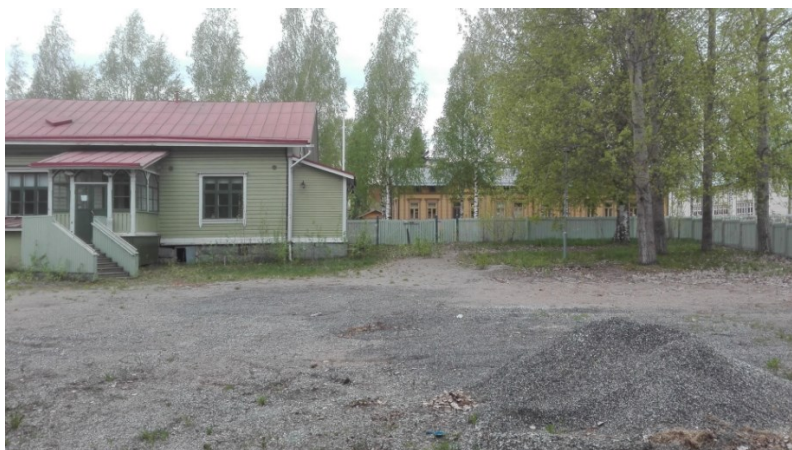
KUVA 17. Tontin pohjoispääty. (Iisalmen kaupunki 2019)
