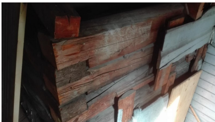
KUVA 11. Hirsirakenne ullakon portaiden kohdalla. (Iisalmen kaupunki 2019)
