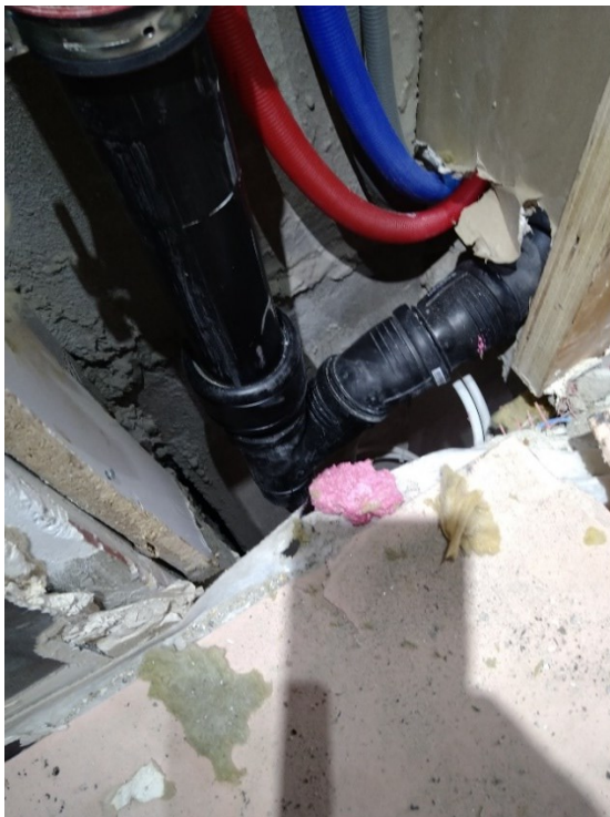
Kuva 3. Keittiön hormiin sijoitettu viemäri ja vesijohdot
