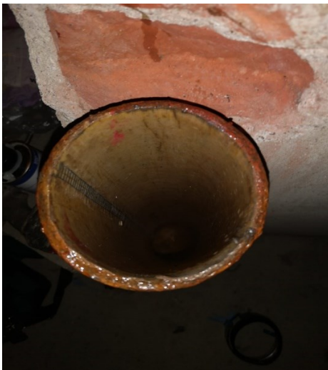
Kuva 5. Sukitettu viemäriputki
