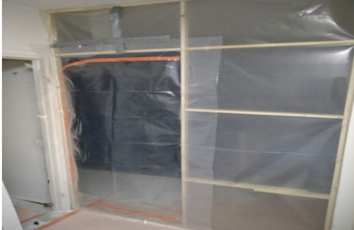
Kuva 7. Asuntoon rakennettu suojaseinä pölyn leviämisen ehkäisemiseksi
