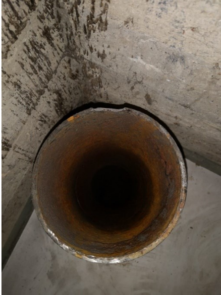
Kuva 4. Mekaanisesti puhdistettu viemäriputki
