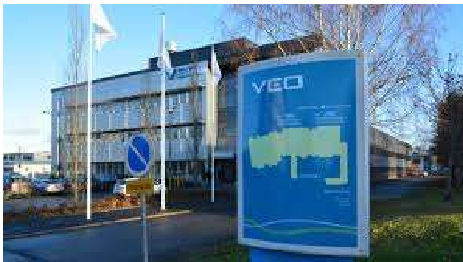
Kuva 1. VEO Oy pääkonttori ja kojeistotehdas
