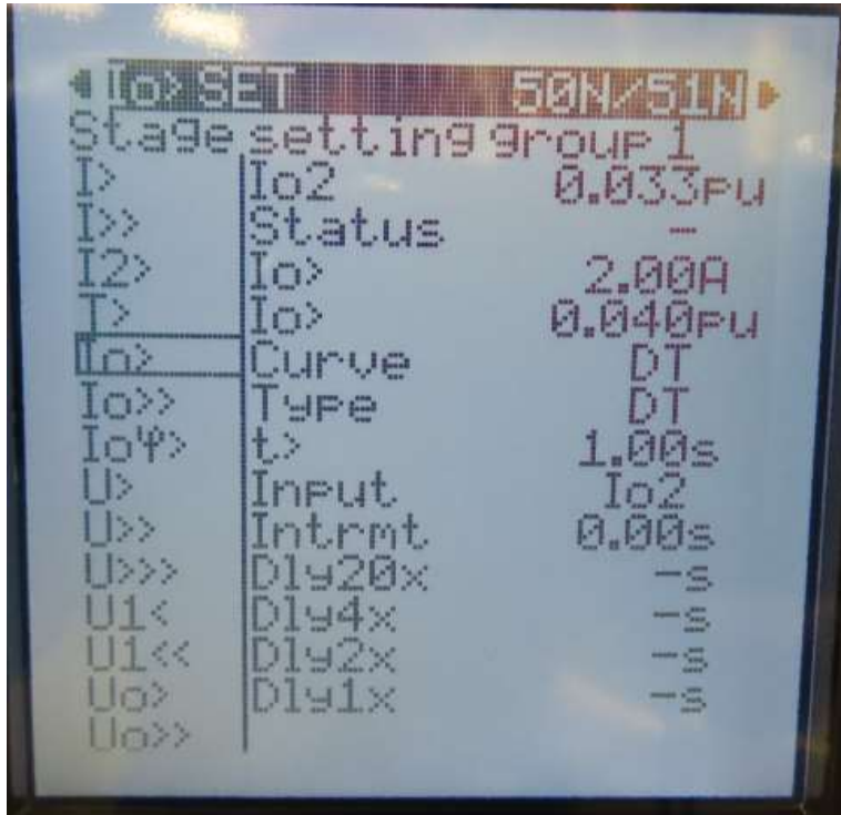
Kuva 21. Maasulkusuojauksen toiminta releen näytöllä
