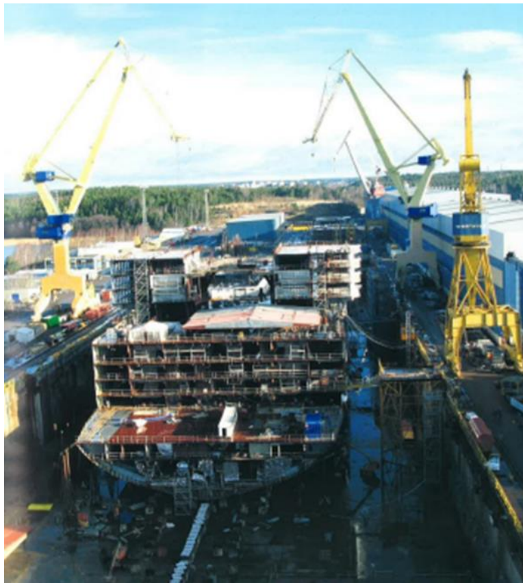
Kuva 11. Rungonkoonti-vaiheessa oleva risteilijä Turun telakan rakennusaltaassa (Pääkkönen, Haapalainen. 2008, 21.)
