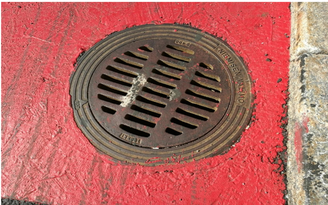
Kuva 10. Pyörätiemassauksen kulumaa Helsingin Hämeentiellä syksyllä 2021 (Kuva: Kati Nurminen)
