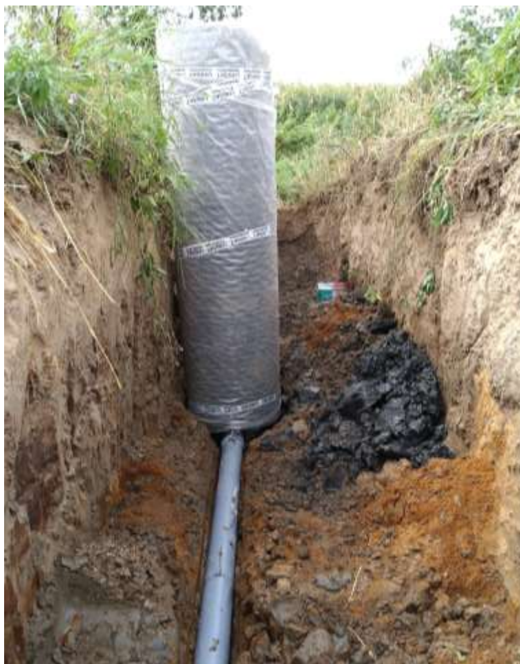
Figur 9. Reglerbrunnens montering på åkerfältet.
