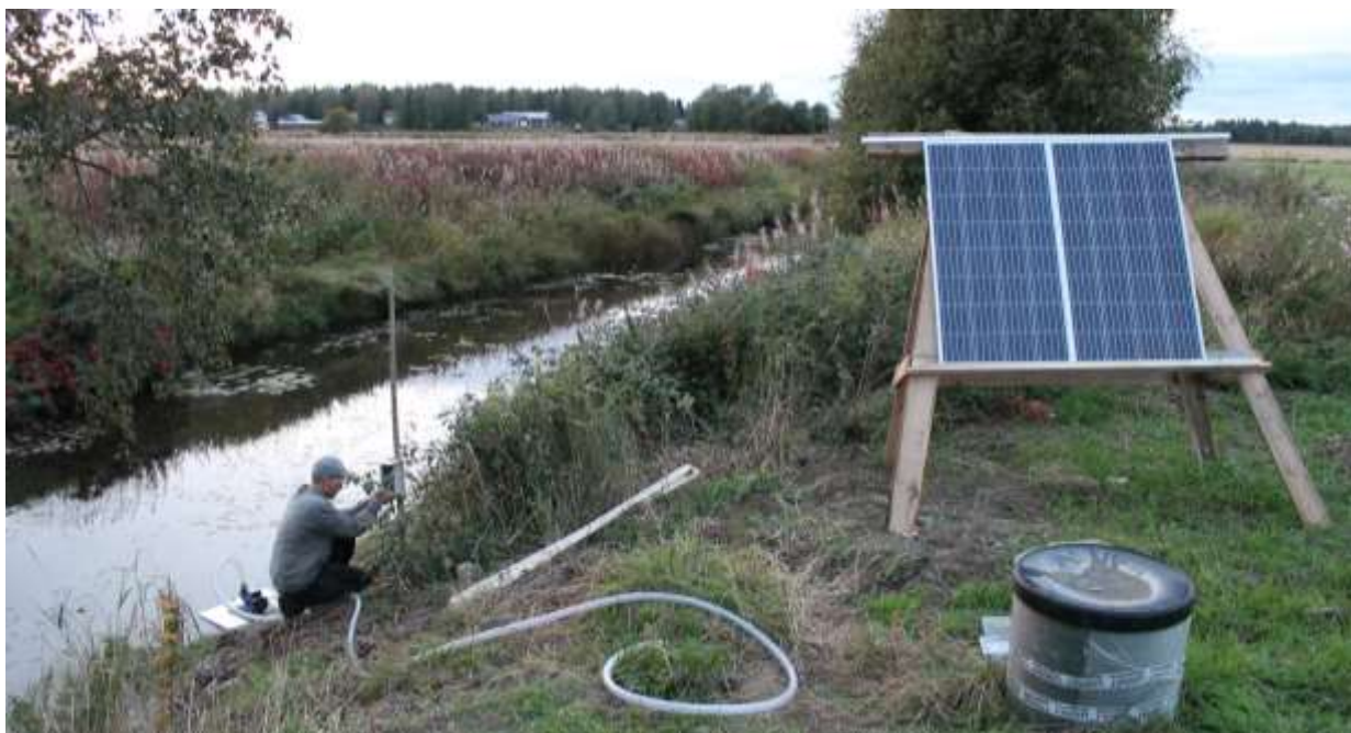
Figur 10. En helhetsbild hur anläggningen är uppbyggd.
