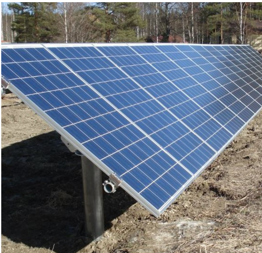
Kuva 7. Aurinkopaneelien maapilariasennus (Finnwind 2021b).
