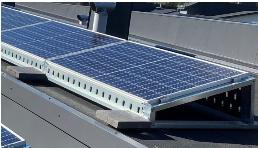
Kuva 4. Aurinkopaneelin painoperustainen asennus.
