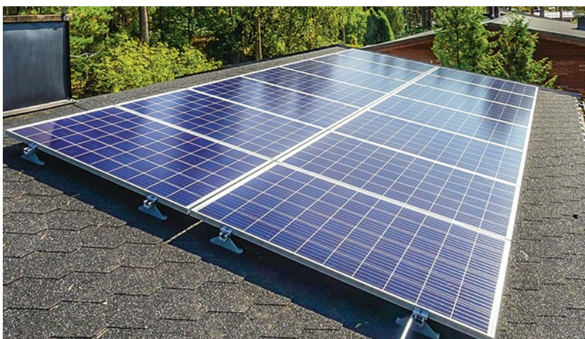
Kuva 5. Nelipisteinen aurinkopaneelien asennus.
