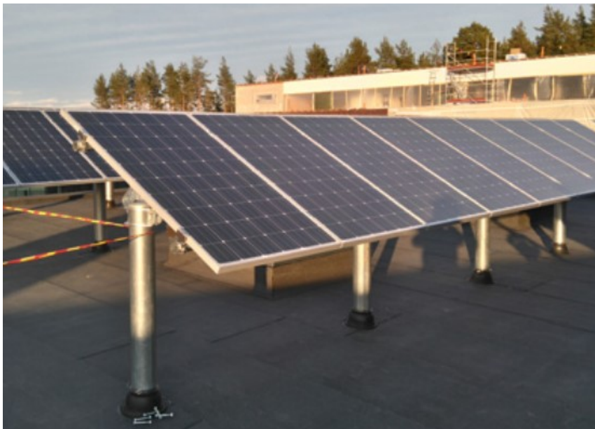
Kuva 6. Aurinkopaneelien pilariasennus (Aurinkopilari.fi 2021).
