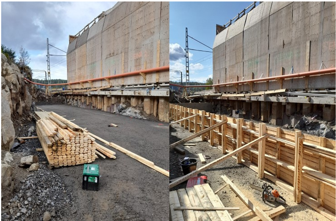
KUVA 7. Peruslaatan muottitustyötä.
