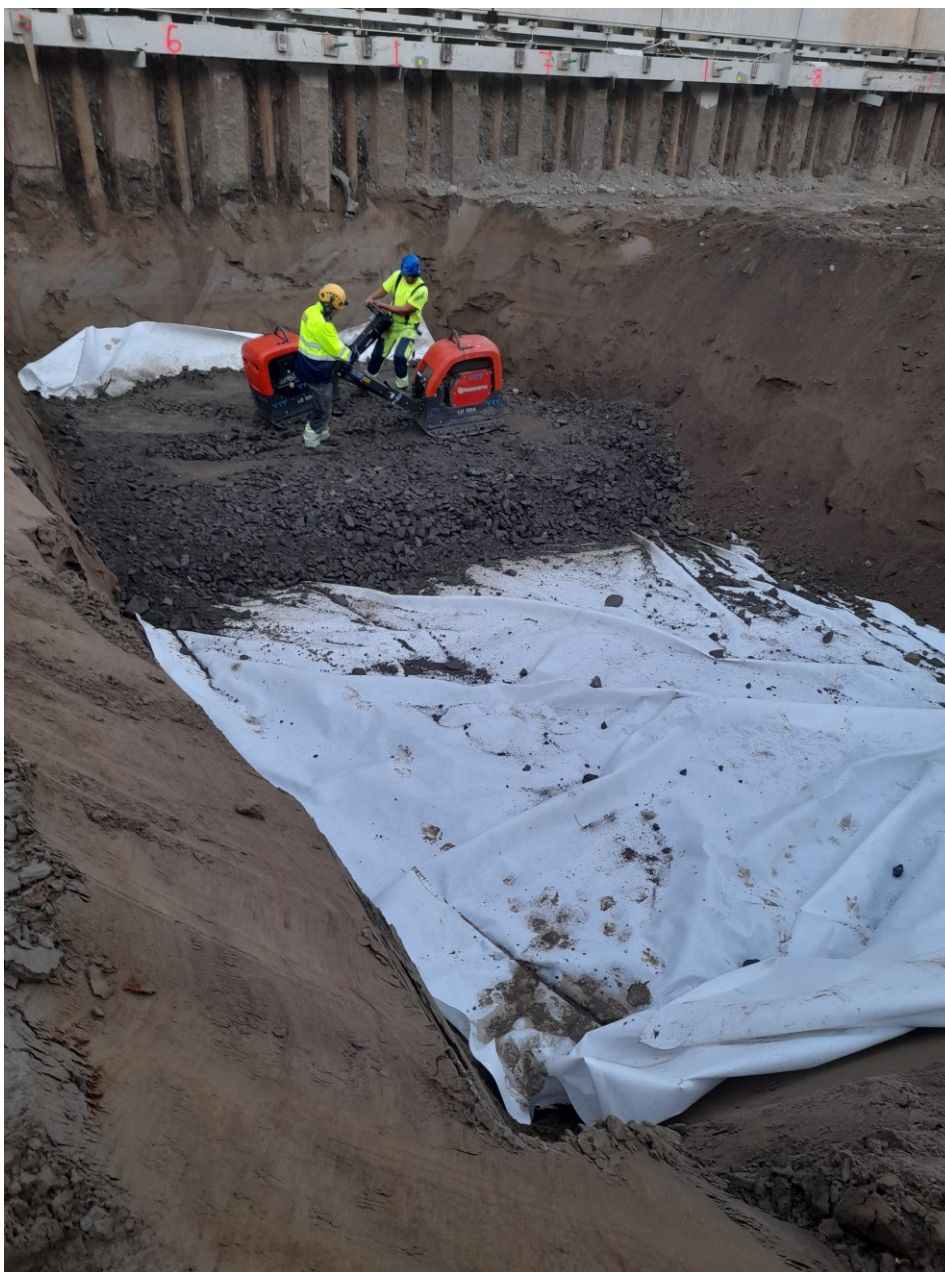
KUVA 5. Massanvaihto käynnissä.
