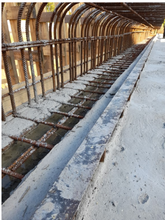
KUVA 14. Kehäjalan yläpää betonoinnin jälkeen.
