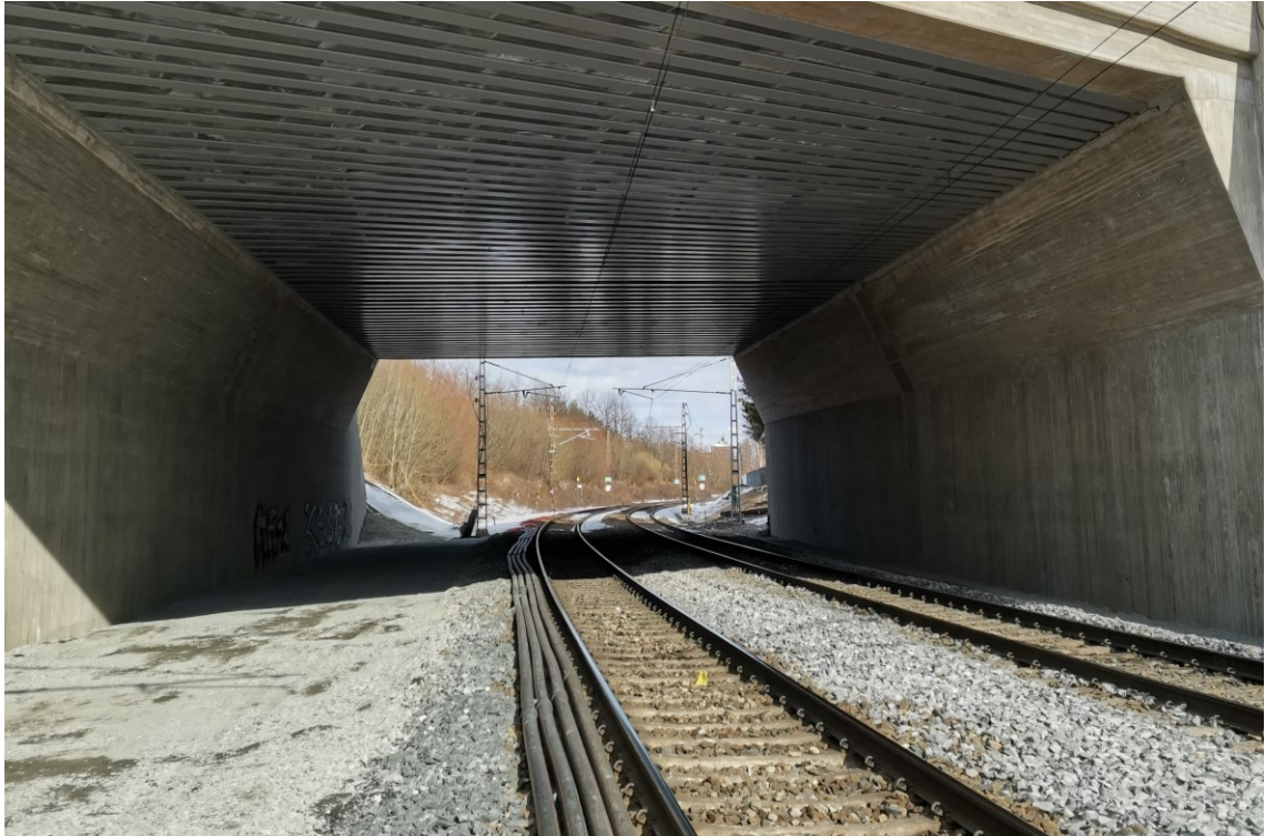
KUVA 28. Tukiseinärakenne poistettuna täytöt tehtynä.
