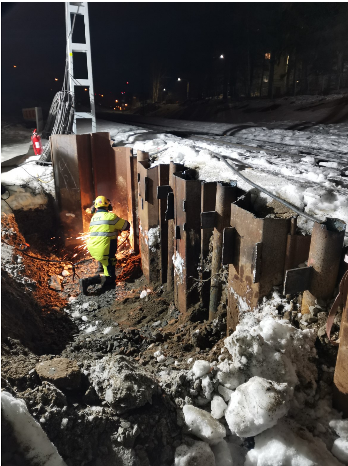
KUVA 27. Paalujen ja ponttiseinän polttoleikkausta.
