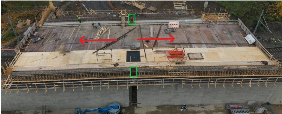
KUVA 18. Vihreällä merkittynä aukot tartunnoissa ja punaisella suunta, johon palkkeja liu'utettiin (MittausGroup).
