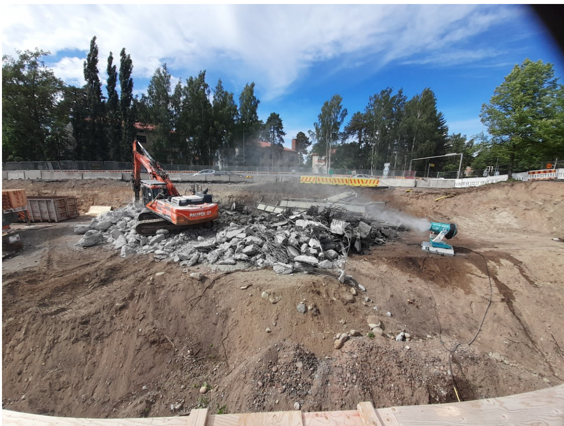
KUVA 4. Betonikappaleiden pulverointi käynnissä.
