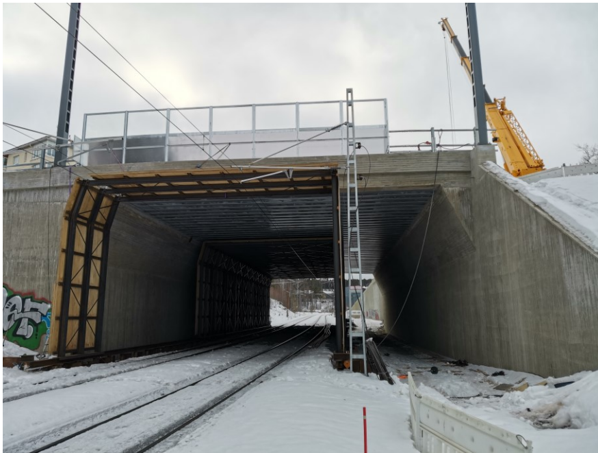
KUVA 25. Suojaseinäelementti vinsattuna pois sillan alta.
