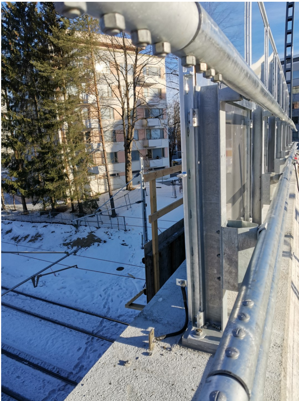
KUVA 22. H4b-luokan tiekaide ja kosketussuojaseinä asennettuna ja maadoitettuna sillalla.
