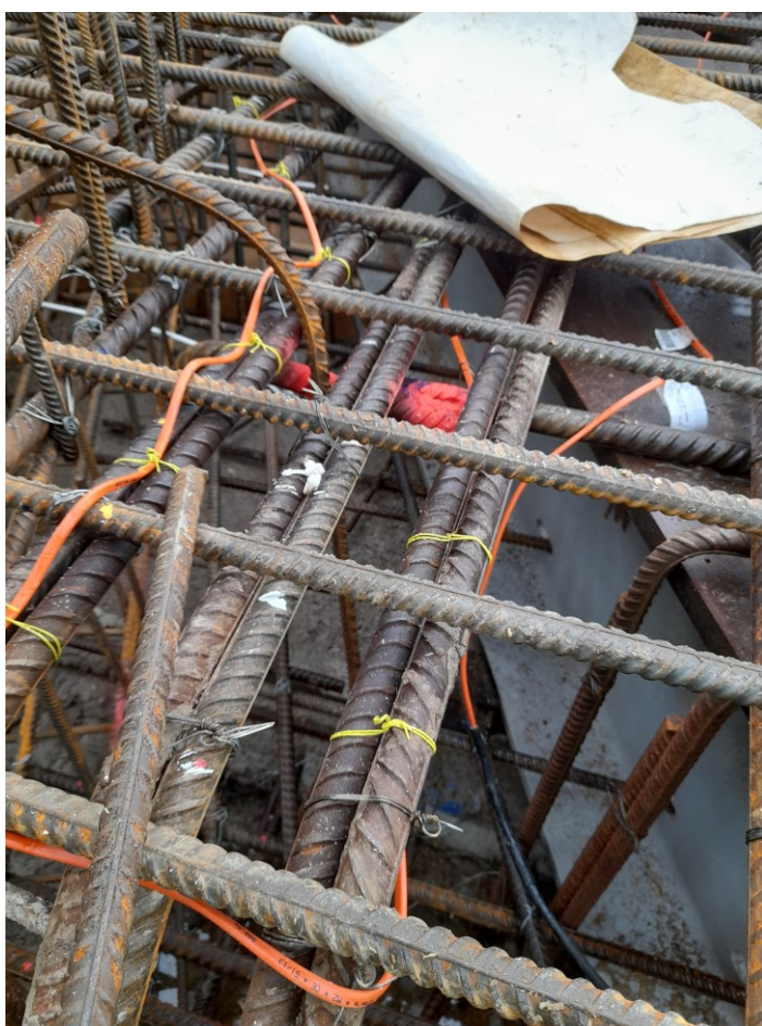
KUVA 20. Betoninkovetuskaapeleita sidottuna raudoitteisiin.
