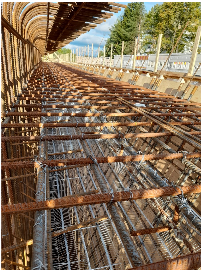
KUVA 13. Kehäjalan yläpinnan raudoitus valmis valusaumaverkko paikallaan.
