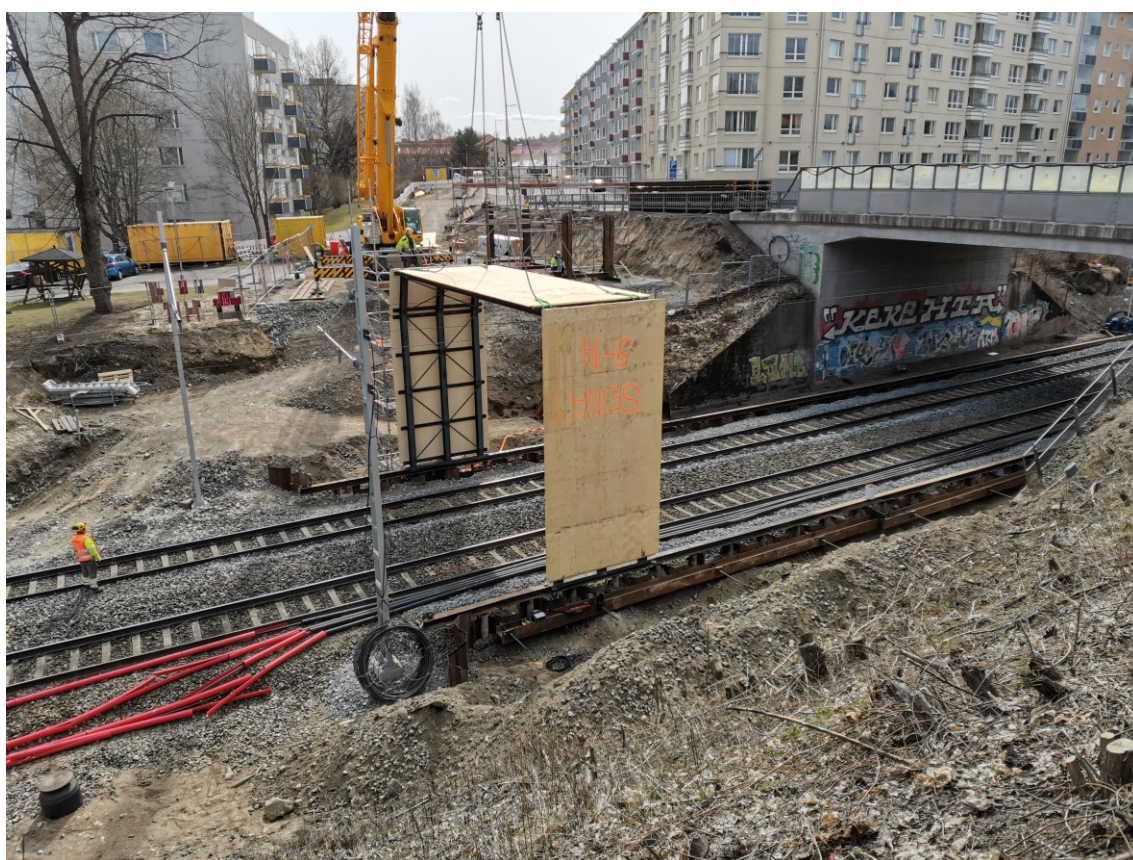
KUVA 3. Suojaseinäelementti laskettuna liukupalkkien päälle ennen vinssausta.
