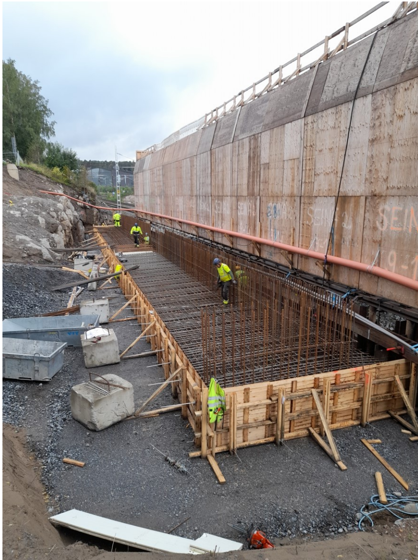
KUVA 8. Raudoitettu peruslaatta.
