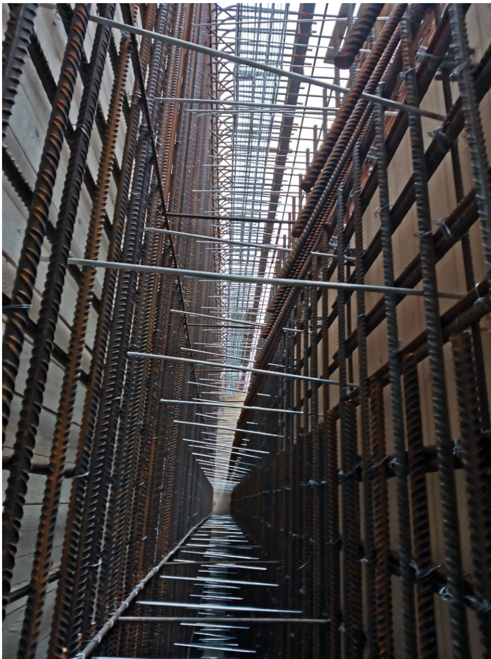
KUVA 12. Kehäjalan muotti sisältäpäin ennen betonointia.
