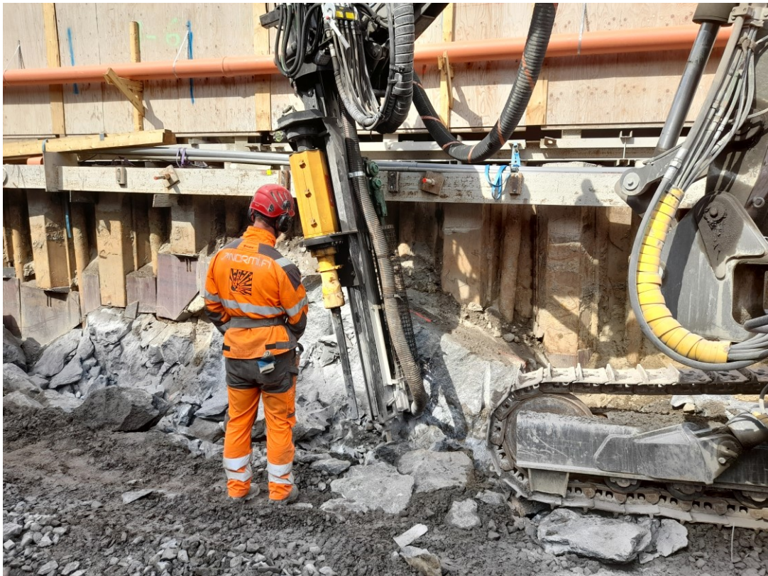
KUVA 6. Kallion kiilausta tukiseinän vierestä.
