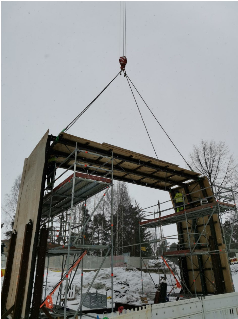
KUVA 26. Suojaseinäelementin purkua jigissä.
