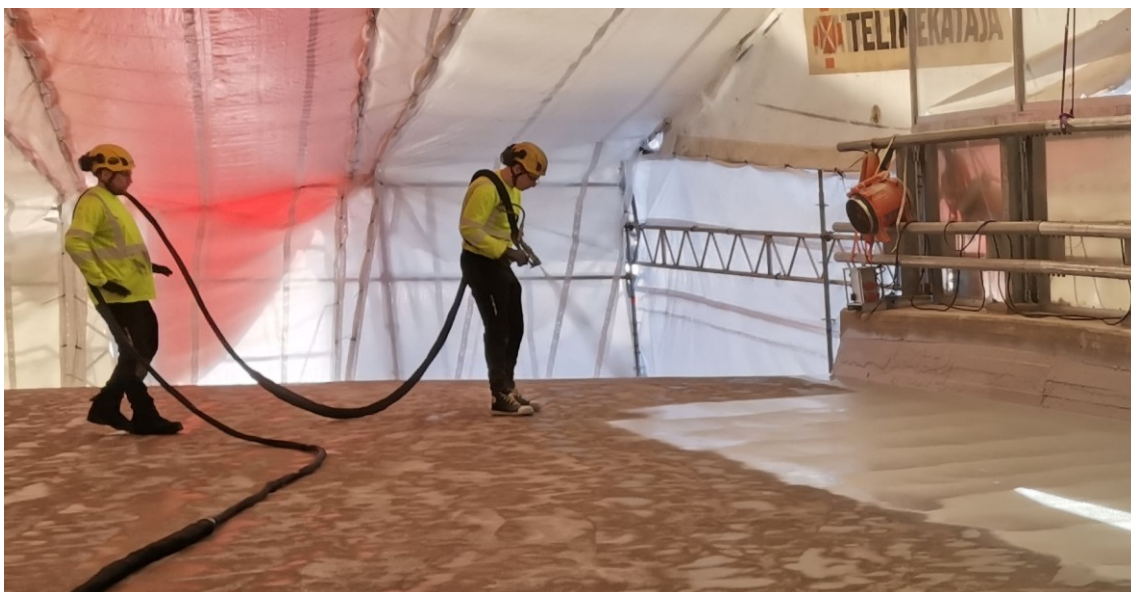
KUVA 24. Vedeneristeen levitys käynnissä.
