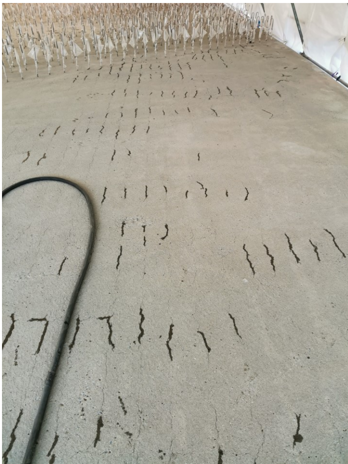
KUVA 23. Imeytetyjä halkeamia kannen pinnassa.
