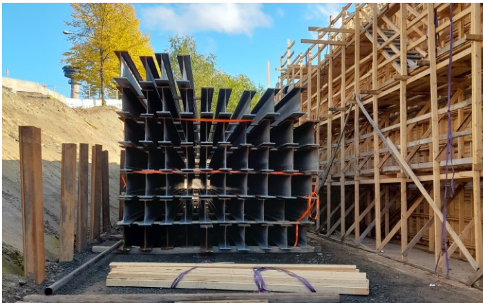
KUVA 17. Kansipalkit varastoituna ennen asennusta.
