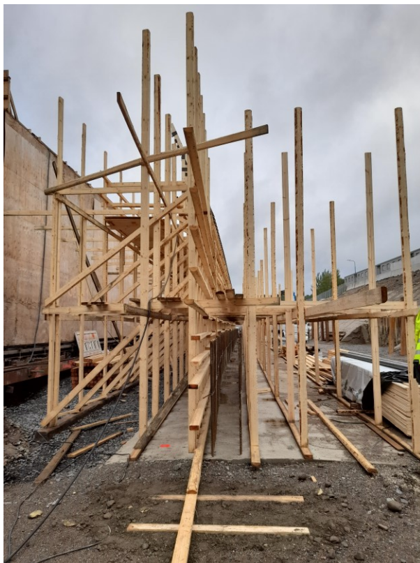
KUVA 10. Kehäjalan telinetyö käynnissä.
