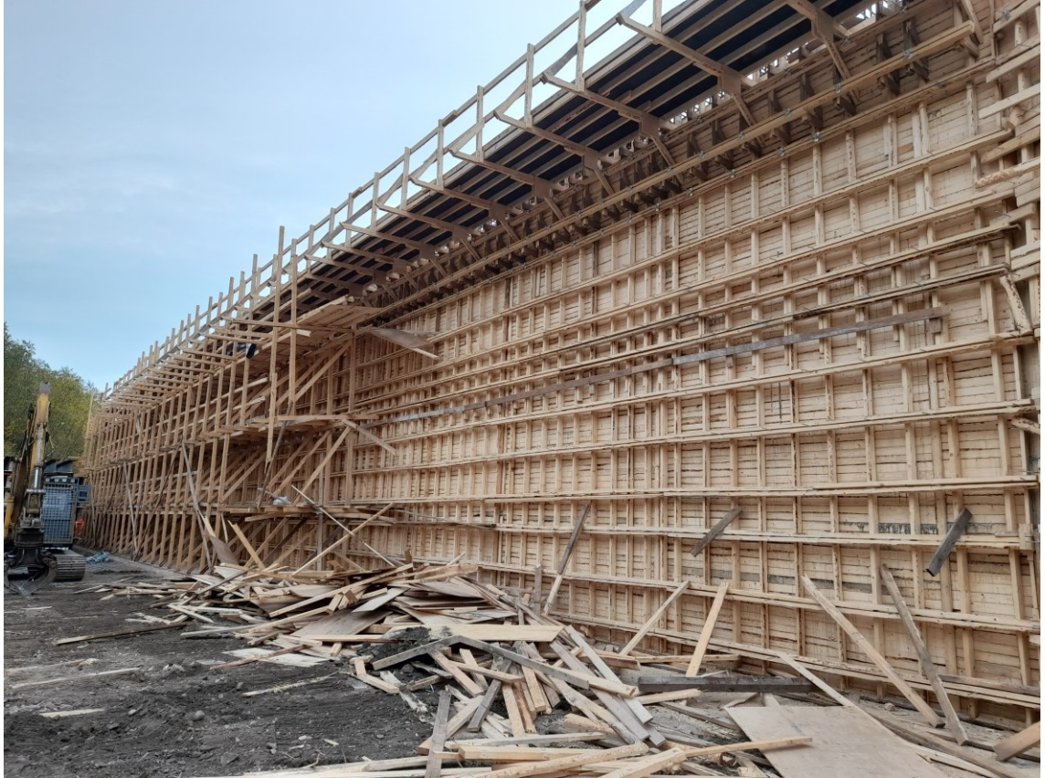
KUVA 15. Kehäjalan telineen purkua.
