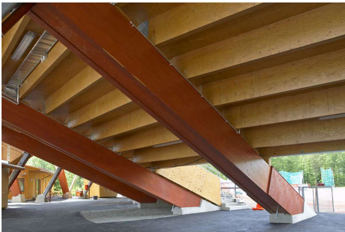
KUVA 16. Puijonlaakson pesäpallostadionin katsomon rakenteita, Kuopio (puuinfo.fi)
