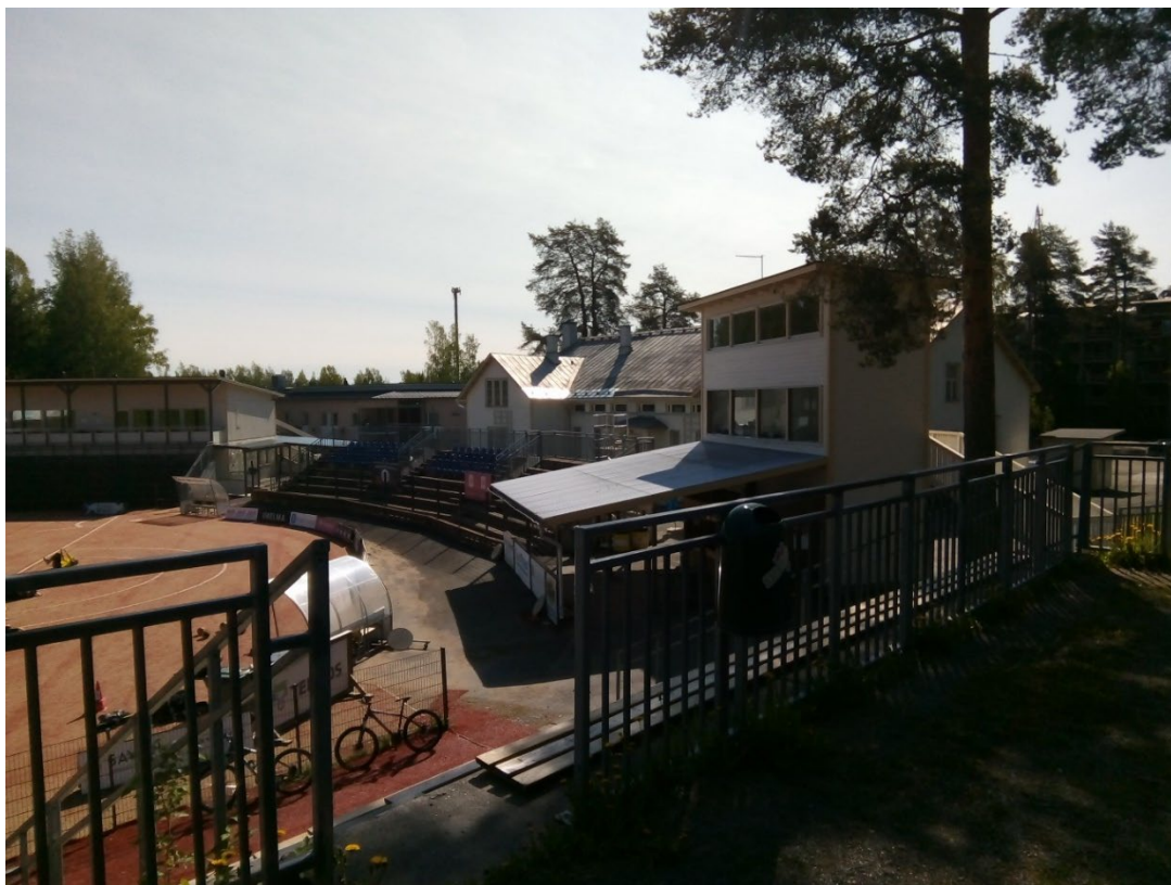
KUVA 4. Lehdistötorni oikealla, Manttaalikunnan talo keskellä ja vasemmalla huoltorakennus nykyisellään. (Marjava 2019-06-03)
