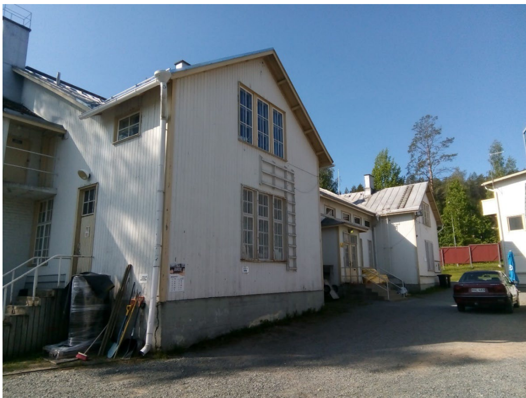
KUVA 2. Manttaalikuopion talon pohjoissivu ja osa lehdistötornia nykyisellään (Marjava 2019-06-03)
