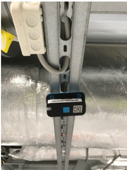
Kuva 10. Työmaan kattoon testauksen ajaksi sijoitettu ankkuri. (29.)
