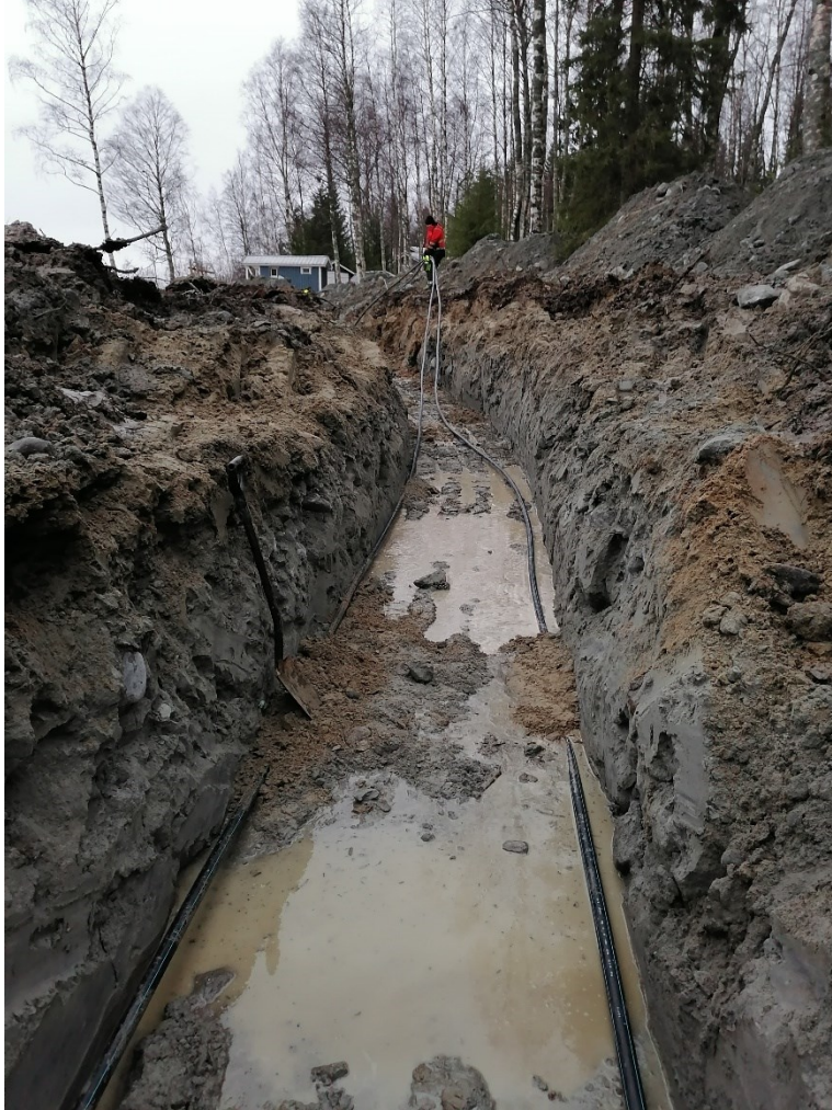
KUVA 2. Maalämmön keruuputkiston asennus kaivantoon (kuva Joel Kaleva)
