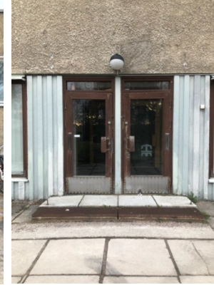
Kuva 31 Kaupalliseen tilaan johtava sisäänkäynti.
