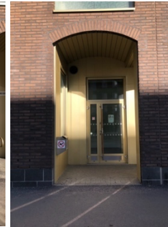
Kuva 59 Kaupallisen tilan sisäänkäynti.
