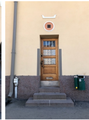
Kuva 18 Kaupalliseen tilaan johtava sisäänkäynti.
