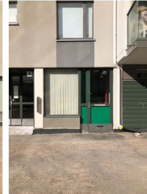
Kuva 41 Kaupallisen tilan sisäänkäynti.
