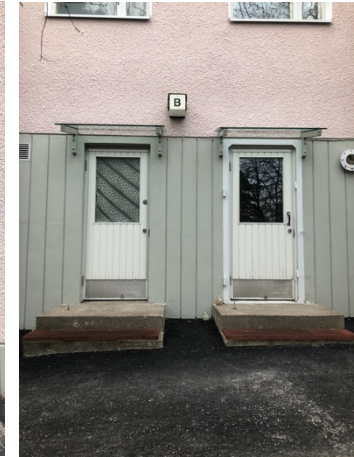
Kuva 27 Kellaritiloihin johtavat sisäänkäynnit.
