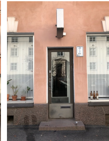
Kuva 23 Kaupalliseen tilaan johtava sisäänkäynti.
