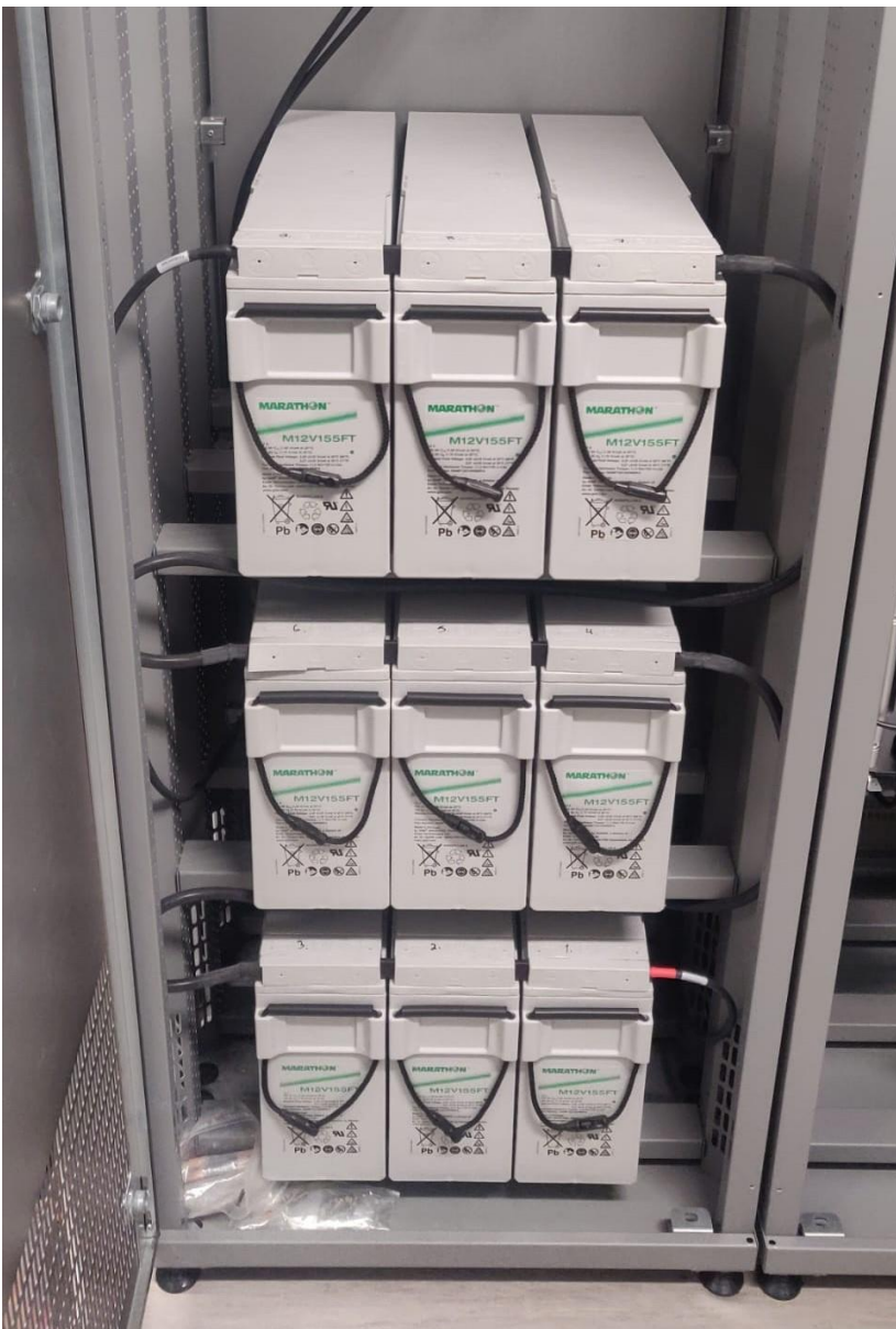
Kuva 6. VRLA-tyyppinen lasivillaerotteinen lyijyakusto.
