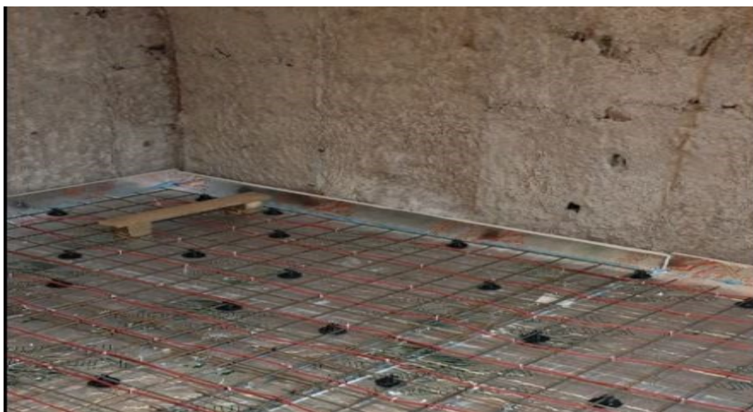
Kuva 8. Perusmuurin pintaa Toja-levyn irrottamisen jälkeen (Roos 2019).
