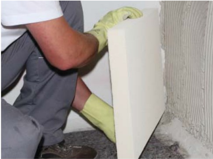
Kuva 2. Homevaurioiden korjaukset Köster-hydrosilikaattilevyillä (Köster vedeneristysjärjestelmät, hydrosilikaattilevy).
