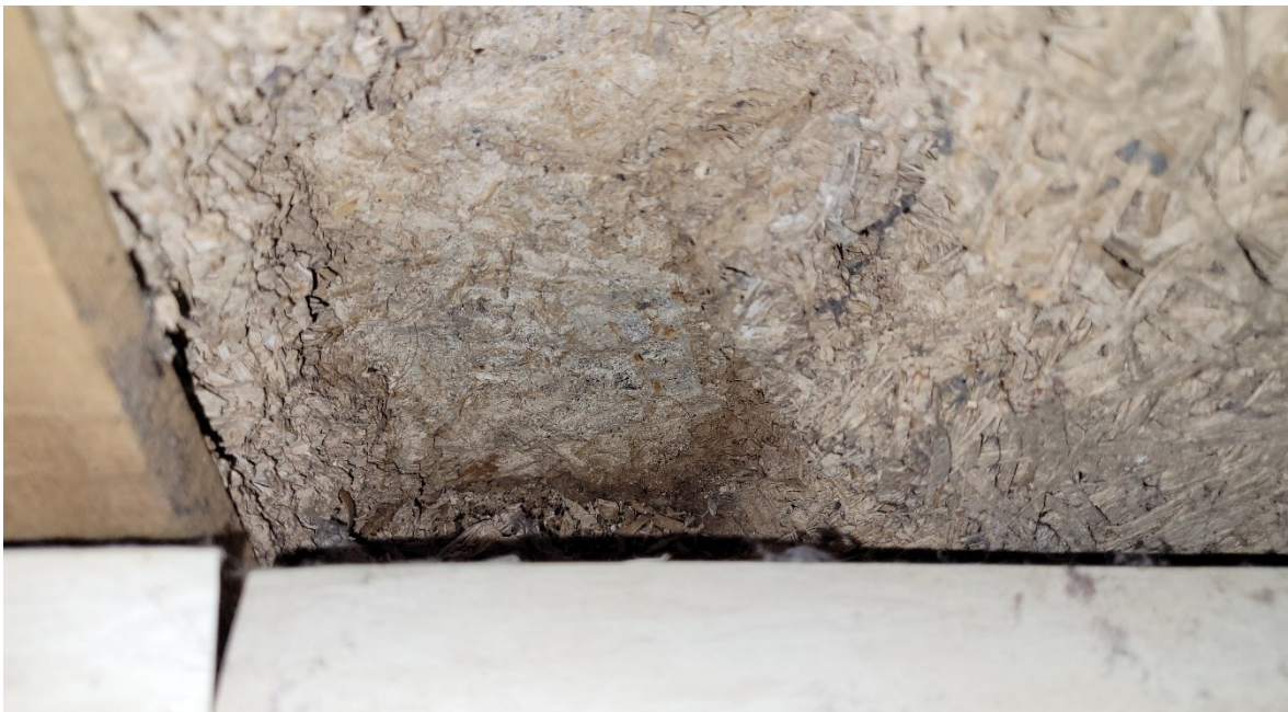
Kuva 1. Avattu seinärakenne seinän ja alapohjan liittymäkohdasta (Kuva: Pekka Roos, 2019)
