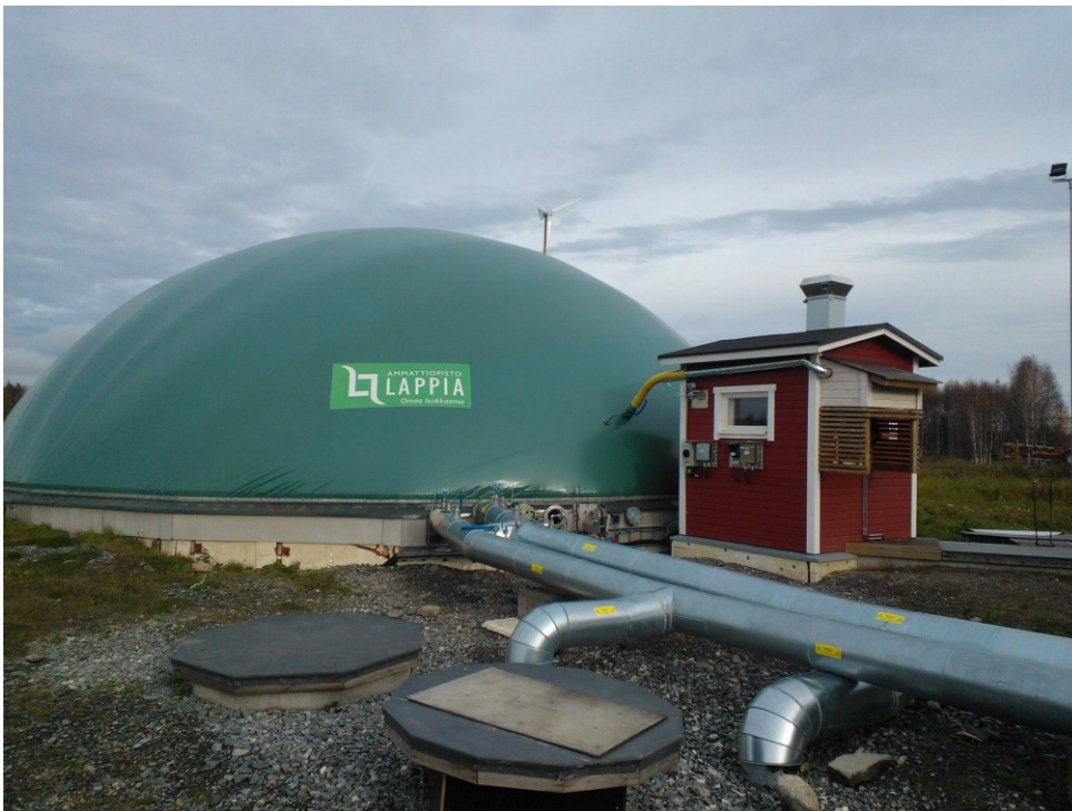
KUVIO 17. Ammattiopisto Lappian Louen biokaasulaitoksen jälkikaasuallas ja kondenssivesikaivot, biokaasuputket sekä hapenottoyksikkö (Kuva: Jarmo Saariniemi)
