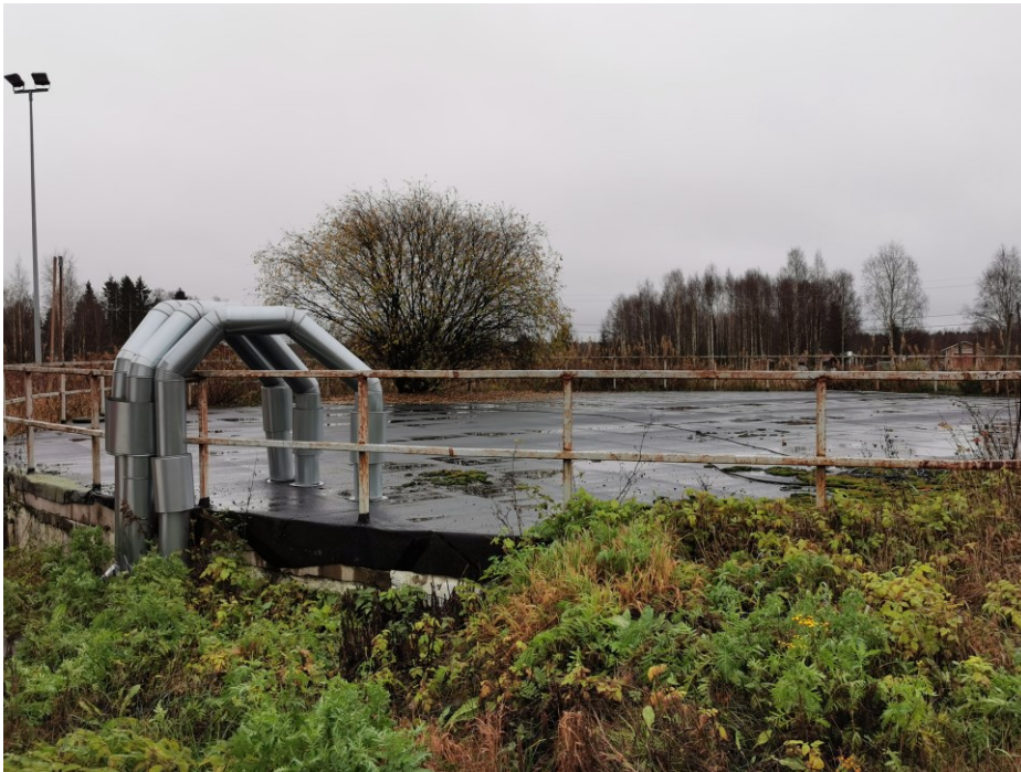
KUVIO 18. Louen biokaasulaitoksen mädätysjäätöksen varastona toimiva katettu lietesäiliö (Kuva: Elisa Lääkkölä)
