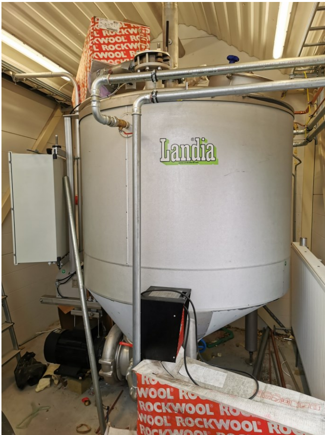
KUVIO 30. Landian hygienisointiyksikkö Louen biokaasulaitoksella (Kuva: Elisa Lääkkölä)
