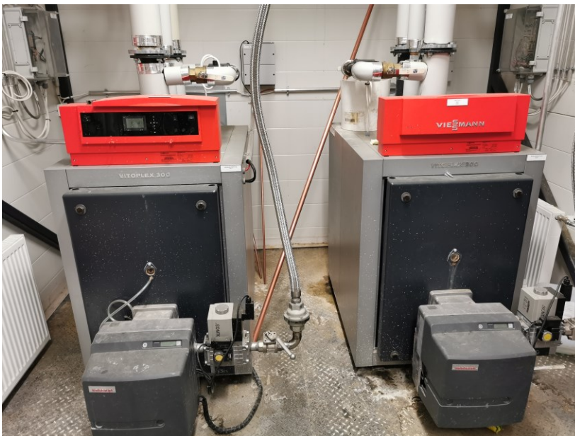
KUVIO 13. Ammattiopisto Lappian Louen biokaasulaitoksen 90 kW:n kaasukattilat (Kuva: Elisa Lääkkölä)
