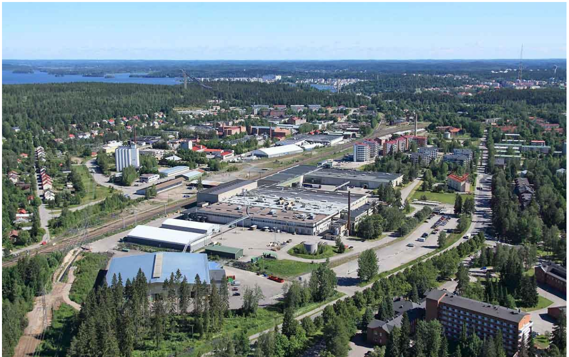
Kuva 2 Lahden tehdas. (Stora Enso, 2022.)
