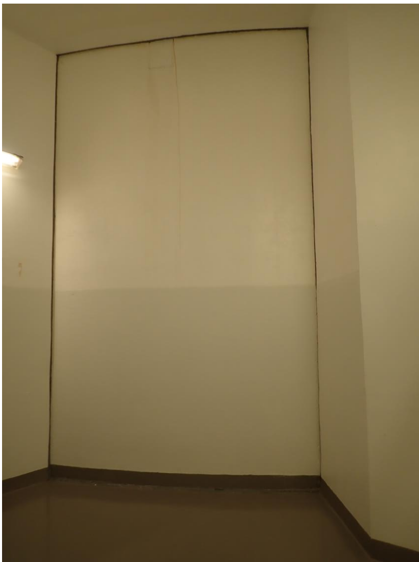
Kuva 5. Suojarakennuksen ja reaktorirakennuksen välinen liikuntasauma kuvattuna reaktorirakennuksen huoneessa (Olkiluoto 2).
