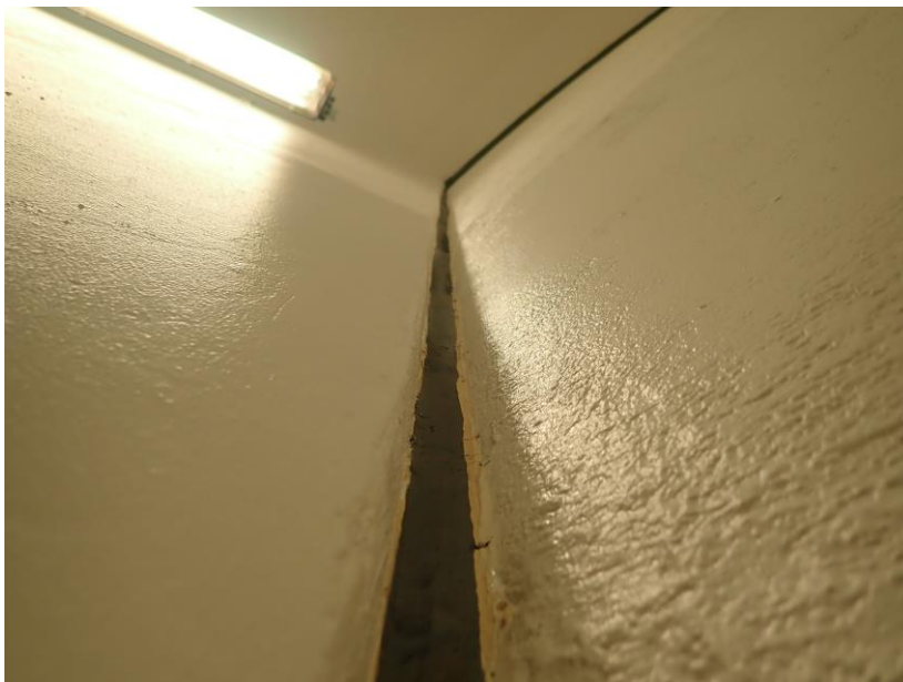
Kuva 6. Reaktorirakennus vasemmalla ja suojarakennus oikealla (Olkiluoto 2).
