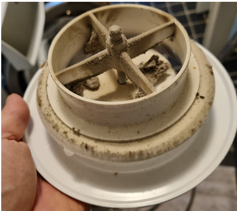
KUVA 14. Likainen poistoilmaventtiili (2021)
