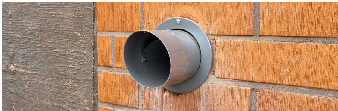
KUVA 20. Poistoilmahajottaja ulkoseinässä (2021)
