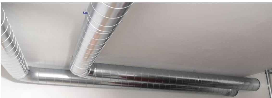
KUVA 3. Sinkityn kierresaumakanavan asennus pientalossa (2022)
