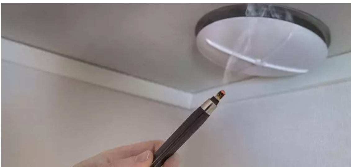
KUVA 4. Lautasventtiili katossa. Ilman vaihtuvuuden havainnointi savukynnällä (Aamulehti 2016)
