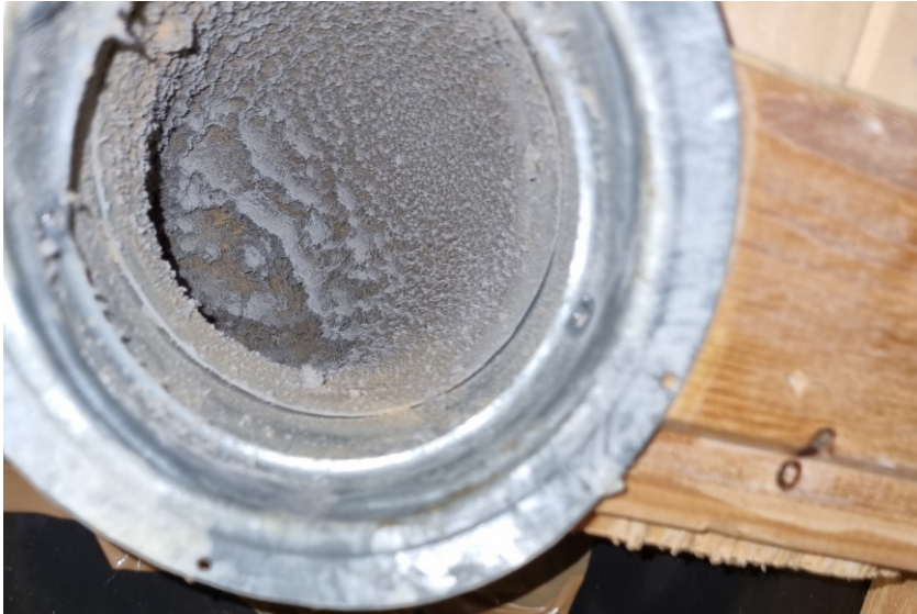
KUVA 13. Likainen kierresaumakanava (2020)
