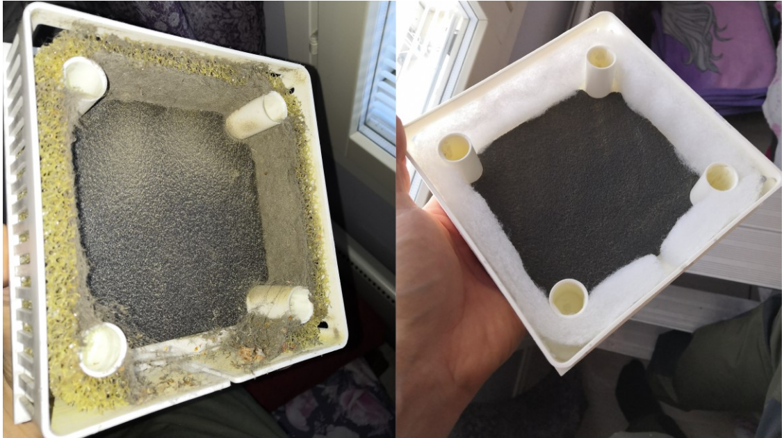
KUVA 12. Vanhan ja uuden korvausilmasuodattimen vertailu (2020)
