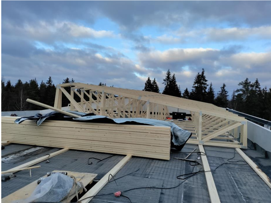
Kuva 6. Vesikaton puutöitä ontelokentän päälle asennetun höyrynsulkukermin päällä. (Kuva: Tuukka Gröhn 2022)
