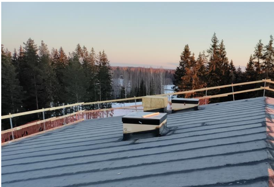
Kuva 7. Ensimmäinen pohjakermi asennettuna vesikatolle. (Kuva: Tuukka Gröhn 2022)
