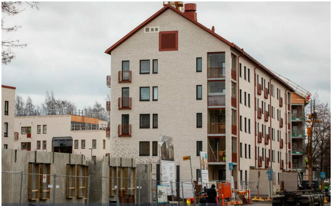
Kuva 1. Harjakatto. (Kuva: Rakennuslehti 2021)
