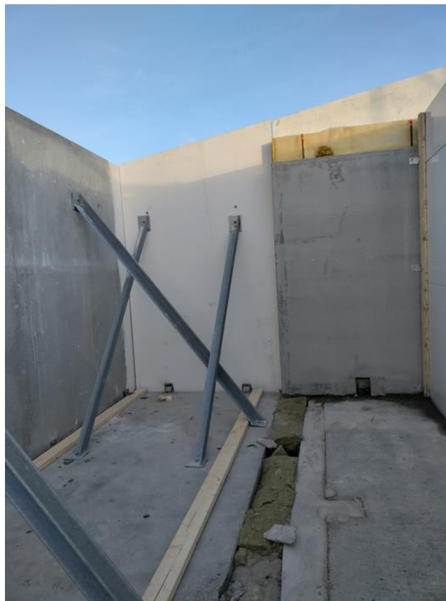
Kuva 13. Vesikataton ympäröivä kuorielementti (Kuva: Tuukka Gröhn 2022)
