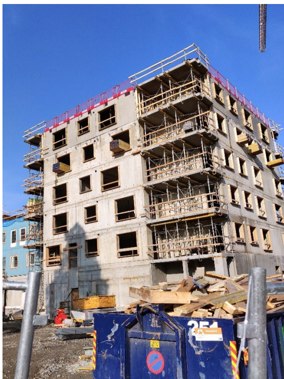
KUVA 4. 10-kerroksinen betonielementtitalo rakennusvaiheessa (Sami-Mikko Tuononen, 2018)
