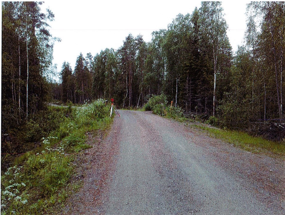
Kuva 1. Yleiskuva siltapaikasta inventointisuuntaan.
