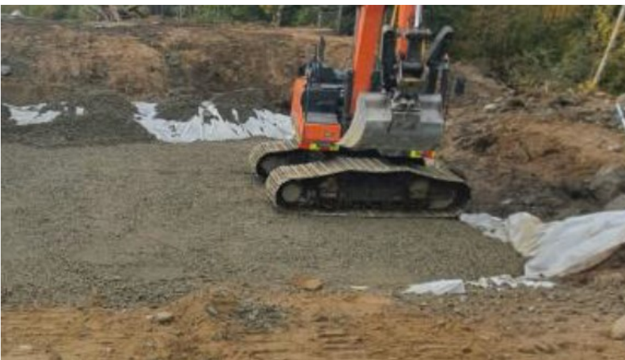
Kuva 11. Suodatinkangas N3 asennettu murskepedin alle ennen täyttötyön aloittamista.
