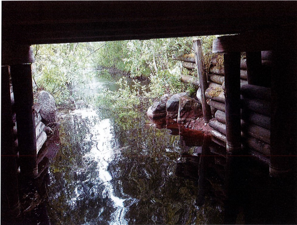
Kuva 3. Yleiskuva sillan alta.
