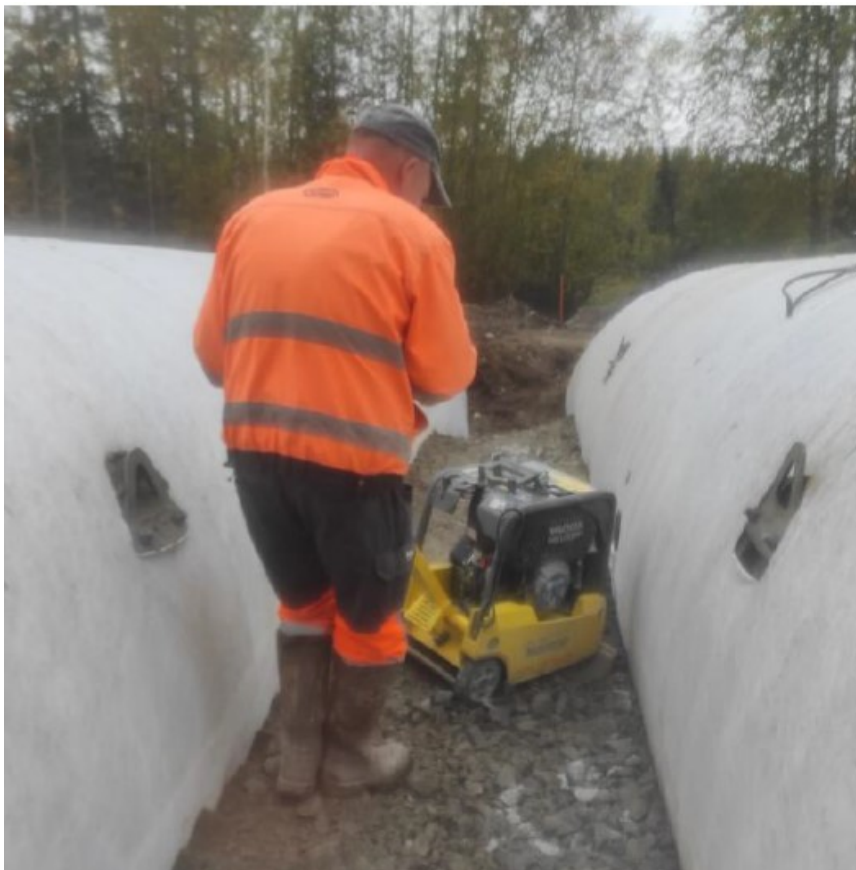
Kuva 13. Jakavan kerroksen tiivistämistä.
