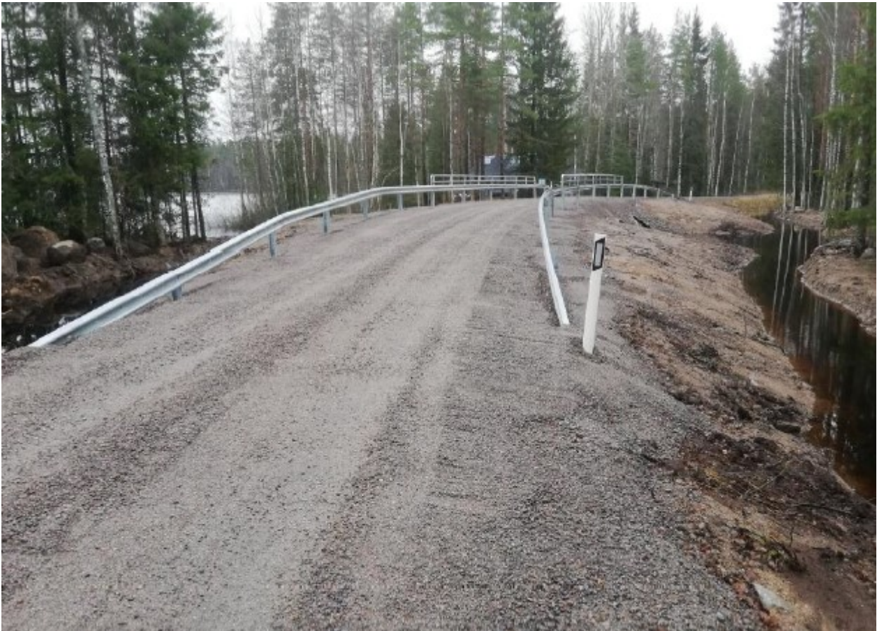
Kuva 16. Alue siistitty ja silta valmis.
