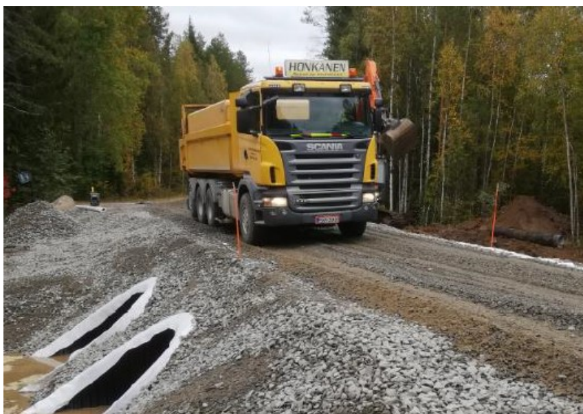
Kuva 14. Kantavan ja kulutuskerroksen levitys ja tiivistys.
