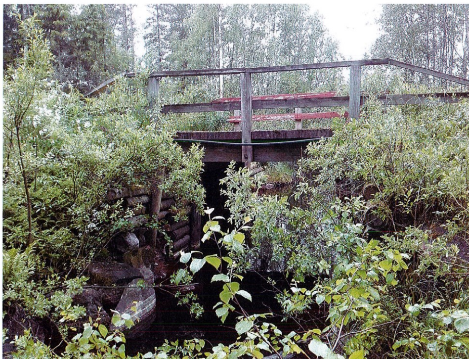
Kuva 2. Yleiskuva sillan oikealta puolelta.
