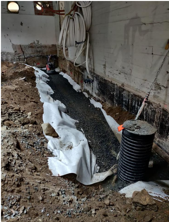
KUVA 14. Salaojaputkiston asennusta kellarikerrokseen.
