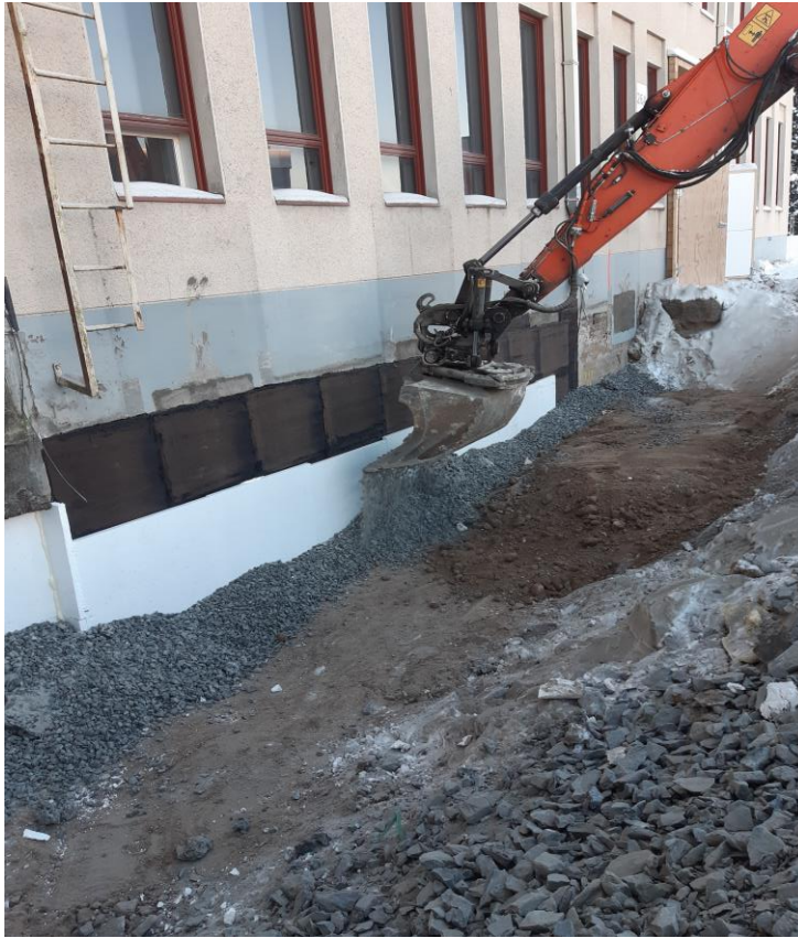
KUVA 9. Pohjoispuolen seinän vierustan täyttöä.
