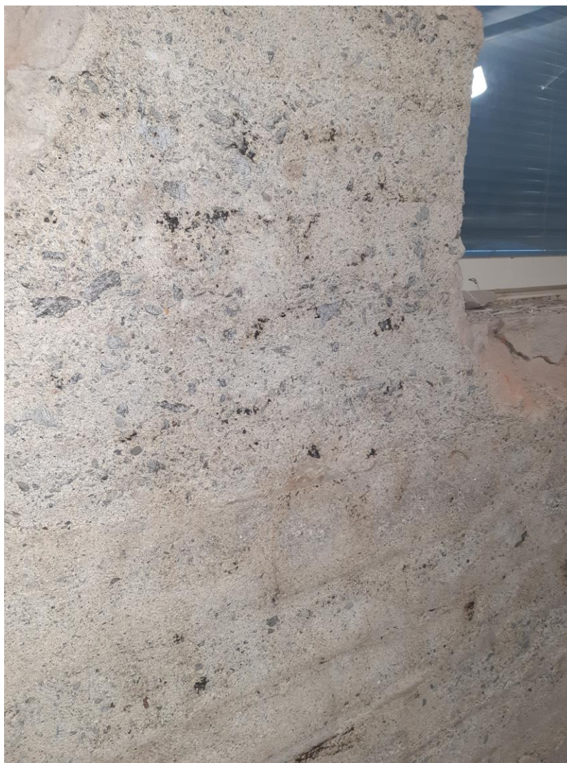
KUVA 4. Kellarin seinästä poistettu bitumikerros.
