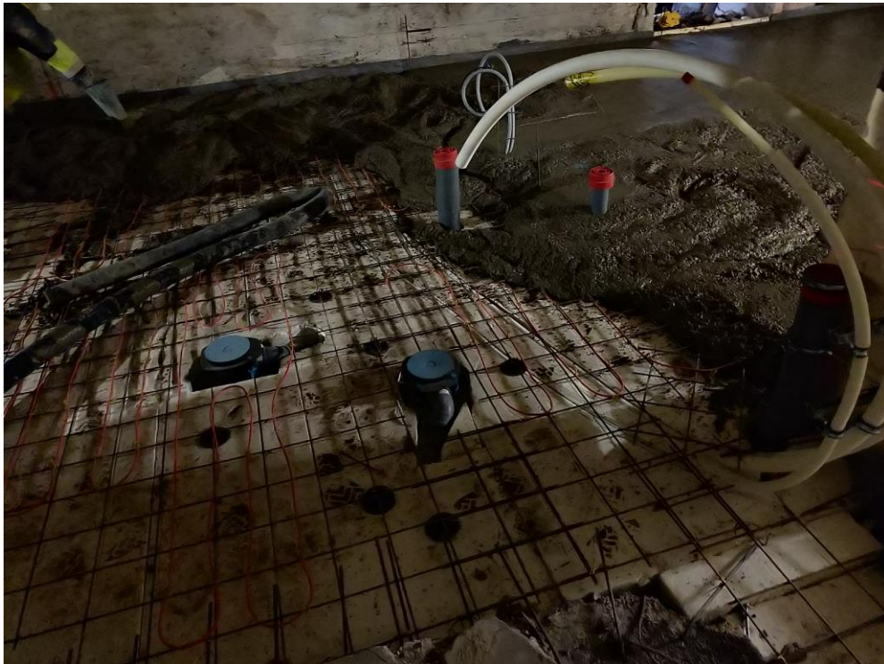
KUVA 13. Kellarikerroksen vanhimman osan sosiaalitilojen lattiavalu käynnissä.
