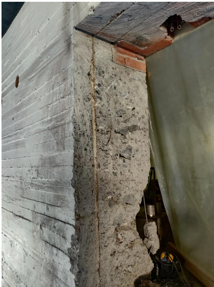
KUVA 5. Toja-levy seinän sisällä.
