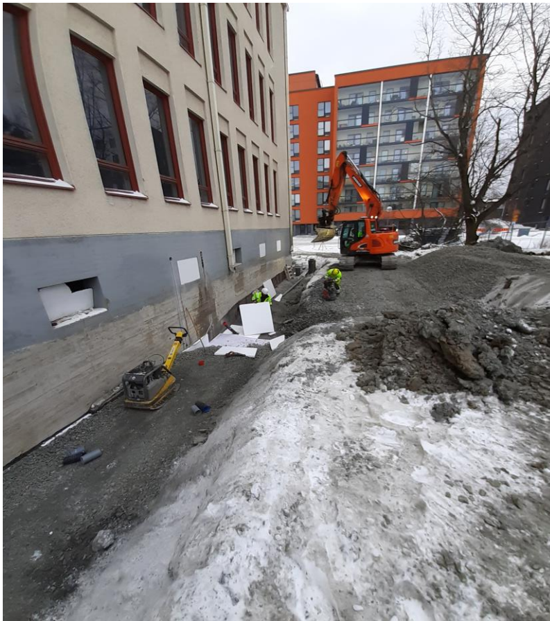
KUVA 11. Länsipuoliskon seinän vierustan kaivutyöt.
