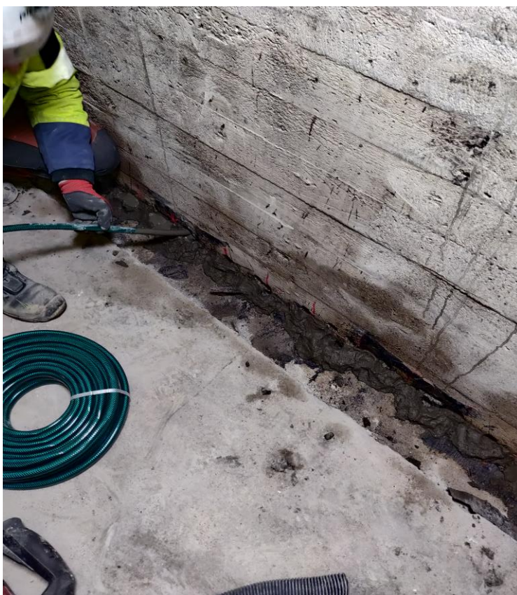
KUVA 21. Xypex Concentrate-tuotteen injektointi porakatkoihin.
