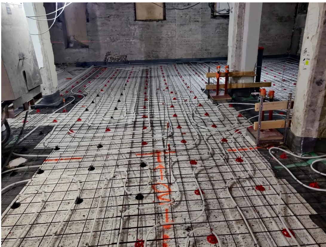
KUVA 23. Radonsuojaa pilarien ja läpivientien ympärillä.
