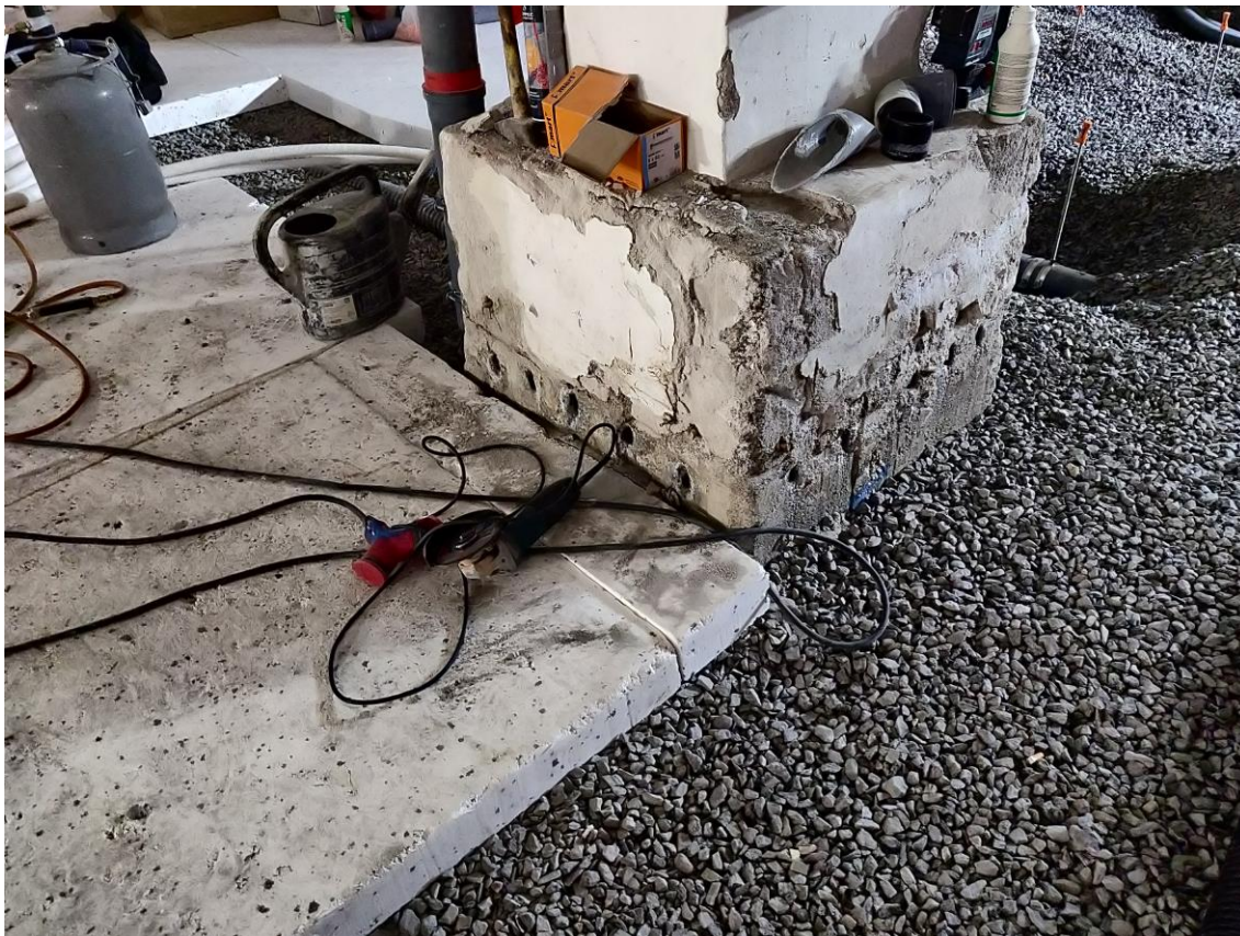
KUVA 22. Injektoidut kapillaarikatkot pilarin alapäässä kellarikerroksessa.
