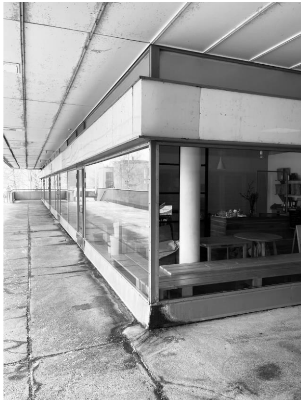
Kuva 20 Lautamuottipintainen betoni yhdistyy lautavuorauksen omaavaan alakattoon.
