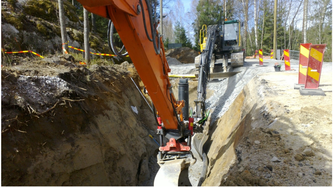
Kuva 32 Kaksi konetta voi vaihdella eri mallien välillä tehdessään yhdessä putkikaivantoa. Toisen kaivaessa putkimallin mukaan, pääsee toinen täyttämään kaivantoa rakennekerrosten pintamallilla. (Kuva: Mattijaakko Määttänen)
