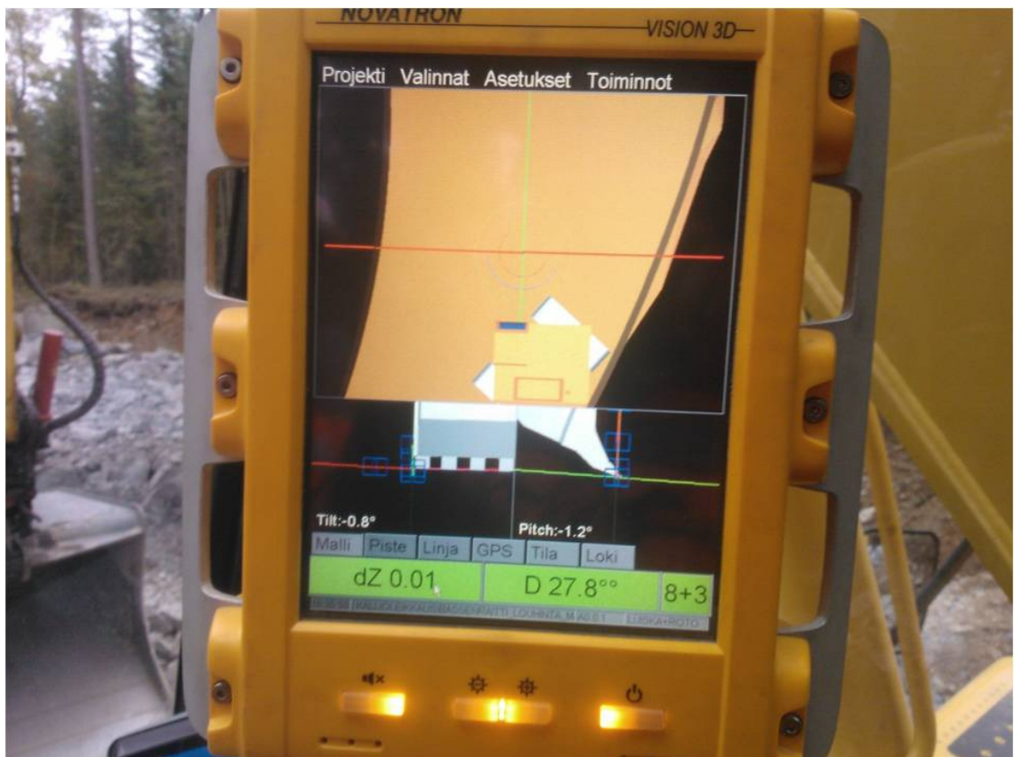
Kuva 19 Kaivinkoneen kauhan asema suhteessa pintamalliin Novatron Vision 3D-koneohjausyksikössä. (Kuva: Lauri Sirviö)
