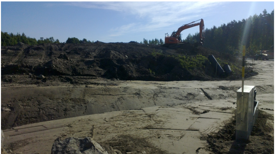
Kuva 43 Ojaluiskien sekä maisemointi- tai meluvallien rakentaminen on pintamallien käytön takia huomattavasti suoraviivaisempaa kuin perinteisillä menetelmillä rakennettaessa. (Kuva: Mattijaakko Määttänen)
