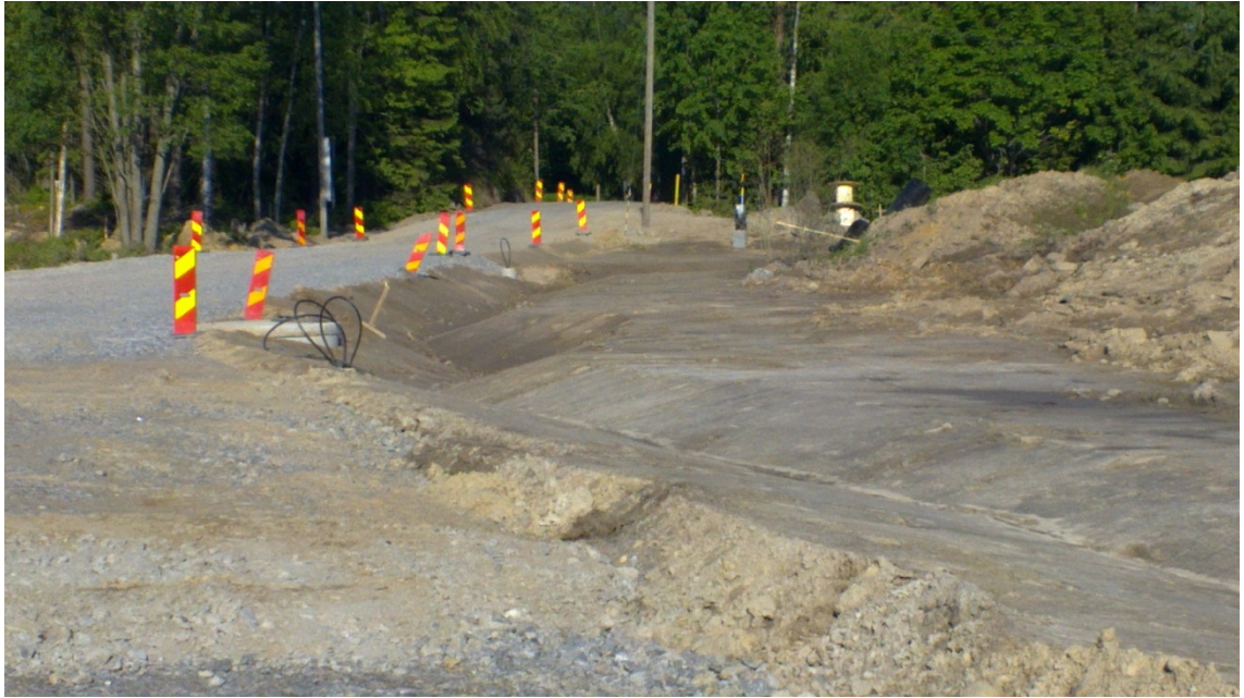
Kuva 42 Koneohjauksella voidaan rakentaa erikoisen muotoisia luiskia ilman maastoon merkitsemistä (Kuva: Mattijaakko Määttänen)
