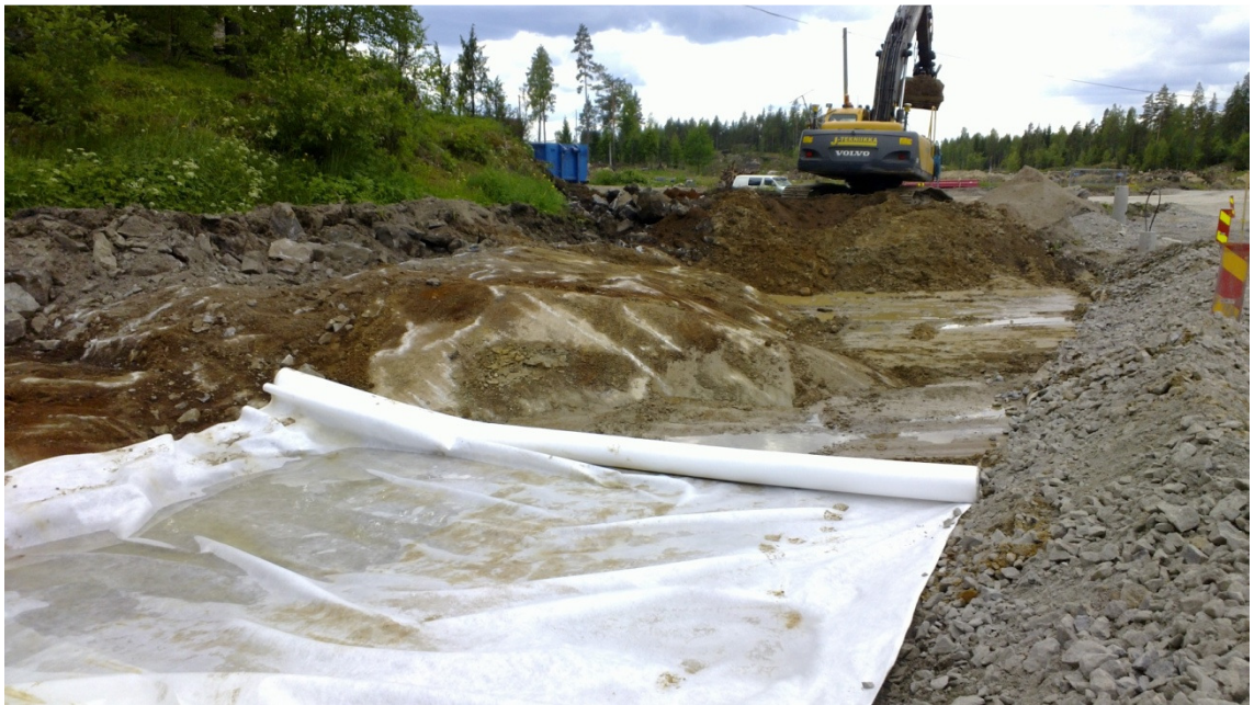
Kuva 41 Kallion reuna voidaan kartoittaa alustavasti kaivinkoneella ja selvittää louhinnan tarpeellisuutta. (Kuva: Mattijaakko Määttänen)
