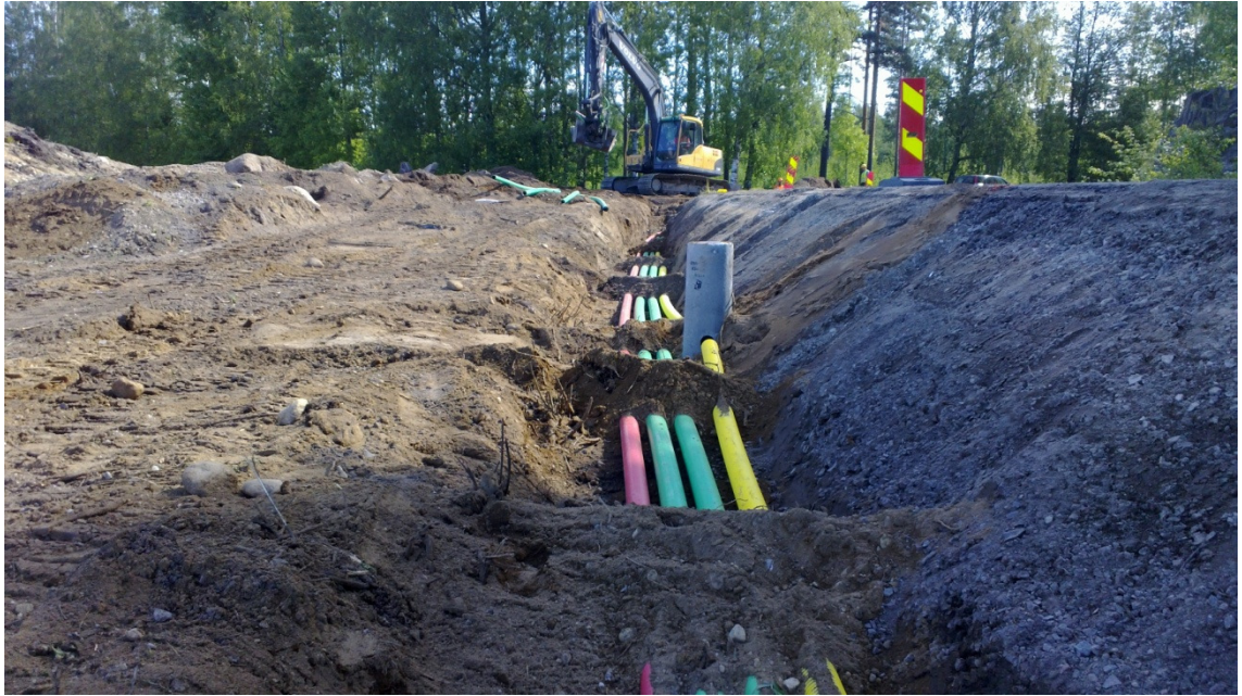
Kuva 33 Putkikanaali Immulassa. 3D-koneohjausjärjestelmät mahdollistavat putkien näkymisen koneohjausyksikössä todenmukaisin värein. (Kuva: Mattijaakko Määttänen)
