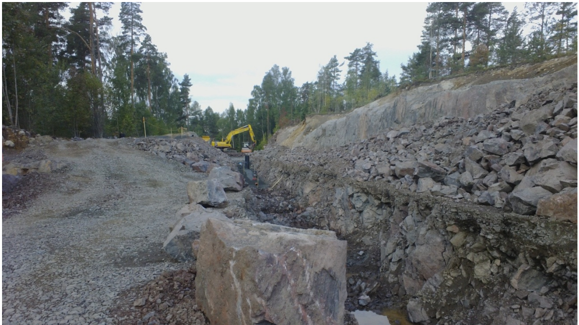
Kuva 40 Bassenkyläntie louhittu, putkikanaalin aukikaivuu käynnissä (Kuva: Mattijaakko Määttänen)
