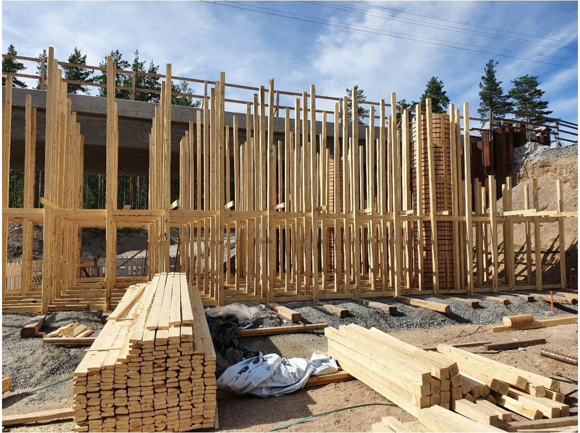
Kuva 2. Sillan kannen telineen rakentaminen (Kuva: Tuukka Parviainen).
