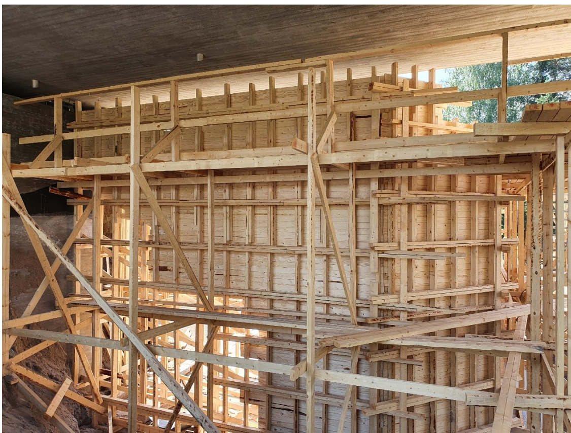
Kuva 1. Sillan maatuen muotti (Kuva: Tuukka Parviainen).
