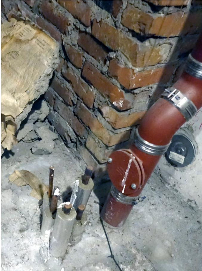
Kuva 5. Käyttövesi- ja lämpöjohtovaraukset sekä tuuletusviemäri ullakolla. (Suomen Talokeskus Oy).
