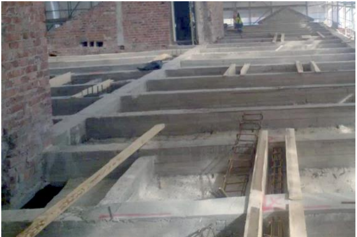
Kuva 4. Ullakon alalattapalkkisto välipohjarakenne. (Suomen Talokeskus Oy).
