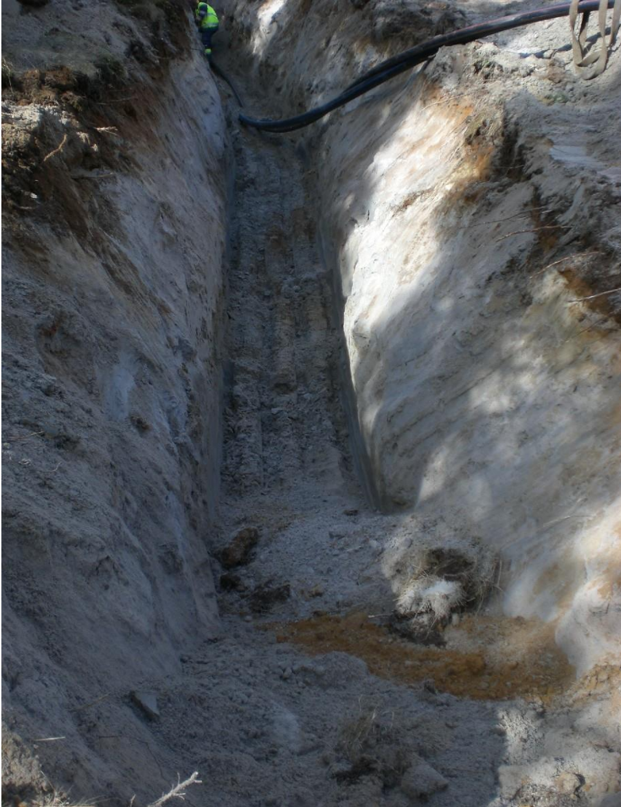
KUVA 4. Luiskattu kaapelikaivanto (2)
