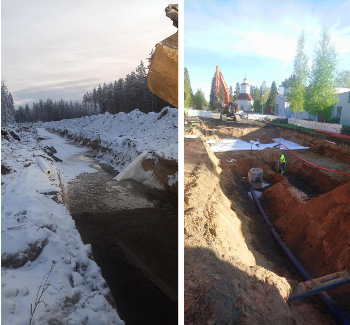
KUVA 3. Kevyenliikenteenväylän- ja kadun massanvaihtokaivanto (6)
