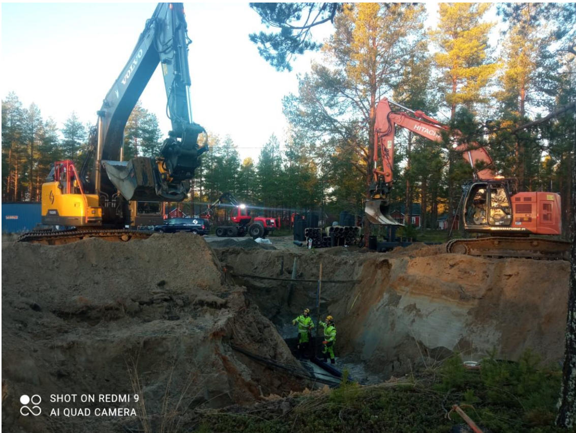
KUVA 2. Luiskattu putkijohtokaivanto (4)
