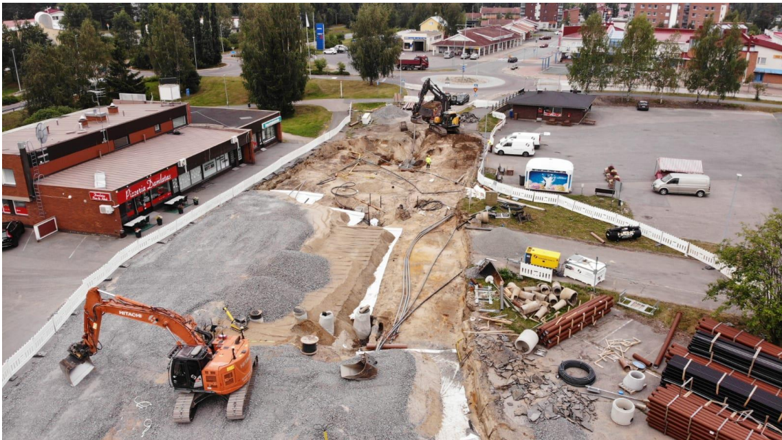
KUVA 1. Yleiskuva katusaneeraustyömaan kaivantotyöstä (3)
