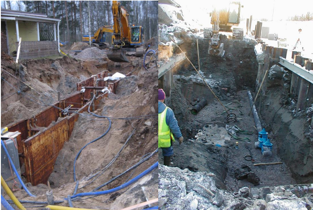
KUVA 5. Tuettuja putkijohtokaivantoja (2)
