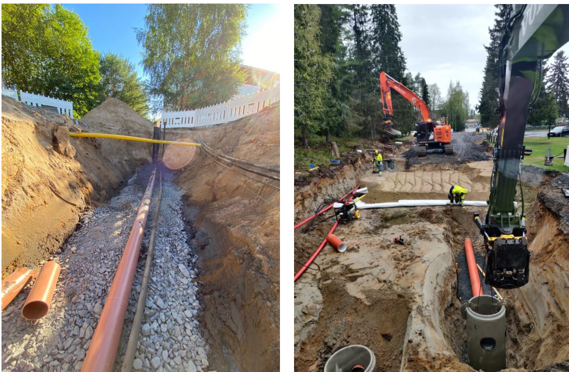
KUVA 6. Tukemattomia putkijohto- ja massanvaihtokaivantoja (9)
