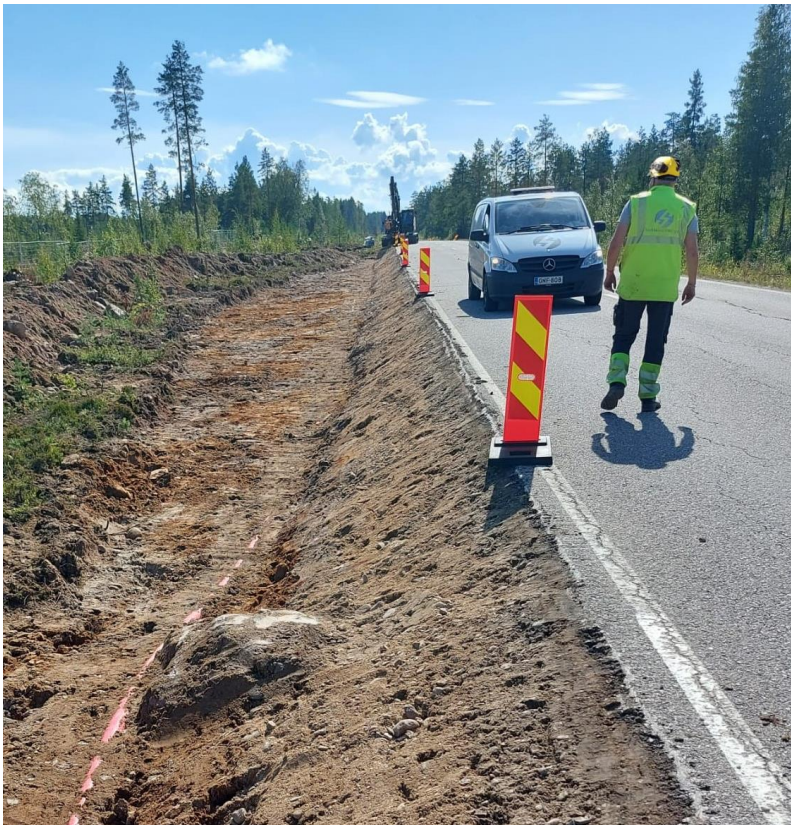
KUVA 16. Sulkupylväitä voidaan käyttää rajaamaan työalue liikenteeltä (17)
