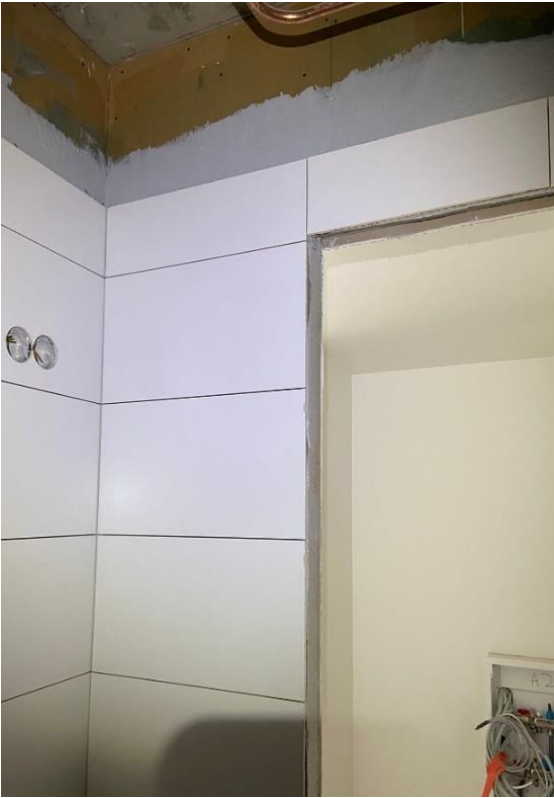
Kuvio 3 Laattojen vaakasaumat tehty oviaukon kanssa tasan.
