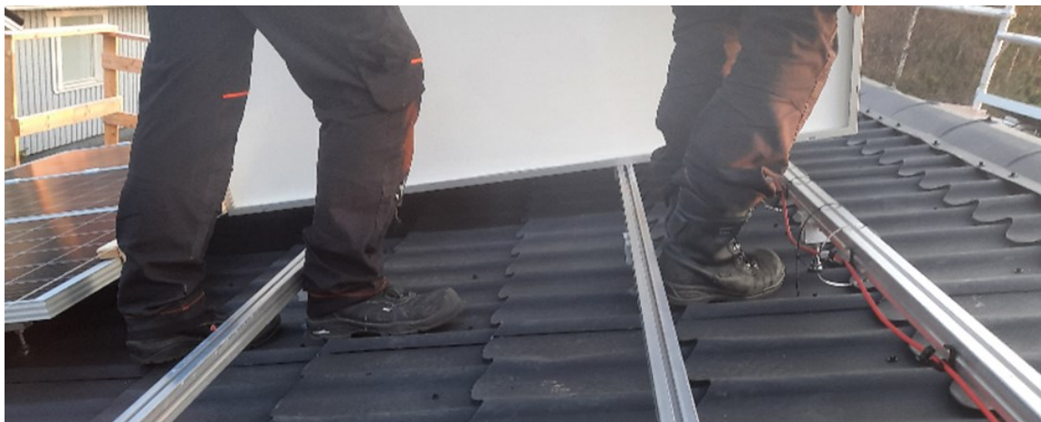
Kuva 41. Paneelin asennus profiilien päälle.
