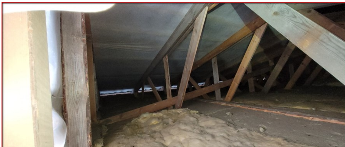
Kuva 33. Kattotuolien rakenne ennen vahvistusta.
