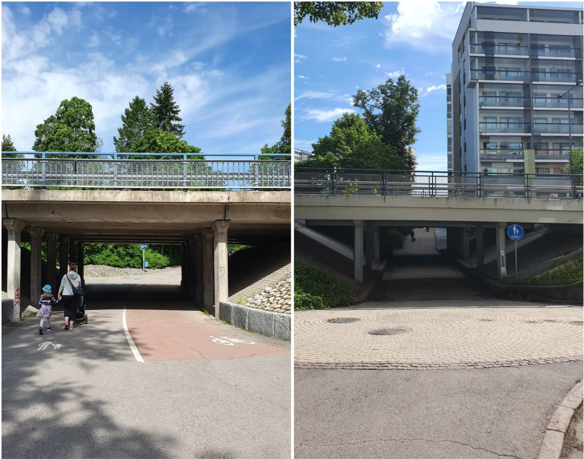
Kuvat 24 ja 25. Kalevanraitin alikulku ja Kauppakaaren alikulku lännestä (Zakharov, 2021).
