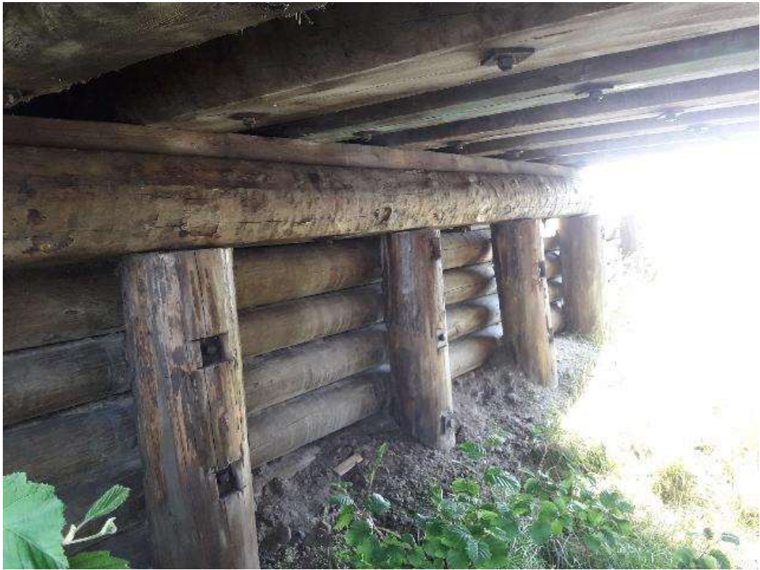
Kuvio 56. Luokka 1, Puinen maatumkirakenne, ei korjaustarvetta (Metsäkeskus 2020)
