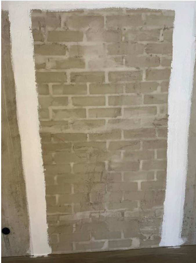
Kuva 1: Bonavan Duo-asunnon umpeen muurattu aukko varaus asuntojen välisessä seinäelementissä. Kuva: Bonava
