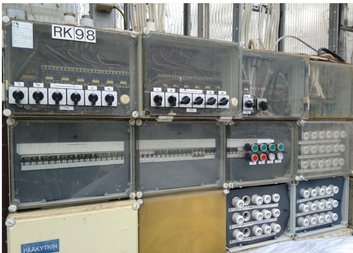
Kuva 10. Turkulaisen Gistele Oy:n valmistama alakeskus RK98, jota voidaan käyttää luukkujen ja verhojen käsiohjaukseen.
