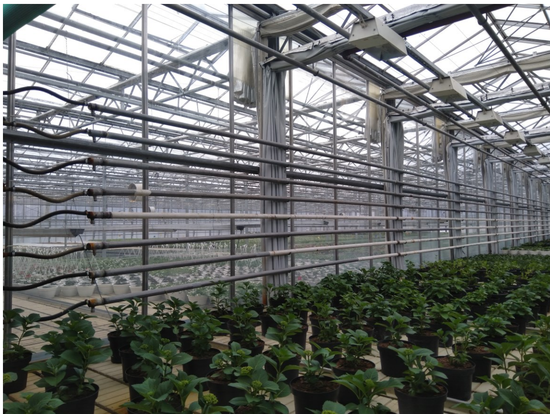
Kuva 13. Kuvan lasitetun seinän edessä ovat lämmityspiirin yläputket, ja niiden takana on kasassa olevia pimennysverhoja sekä osasto C.
