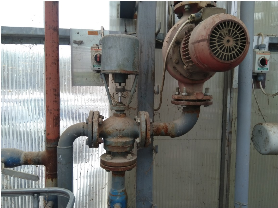
Kuva 15. Lämmityspotkiston toimintaa säätelevä kolmitieventtiili ja yksi lämmityspotkiston pienemmistä pumpuista, joka on teholtaan noin 500 wattia.
