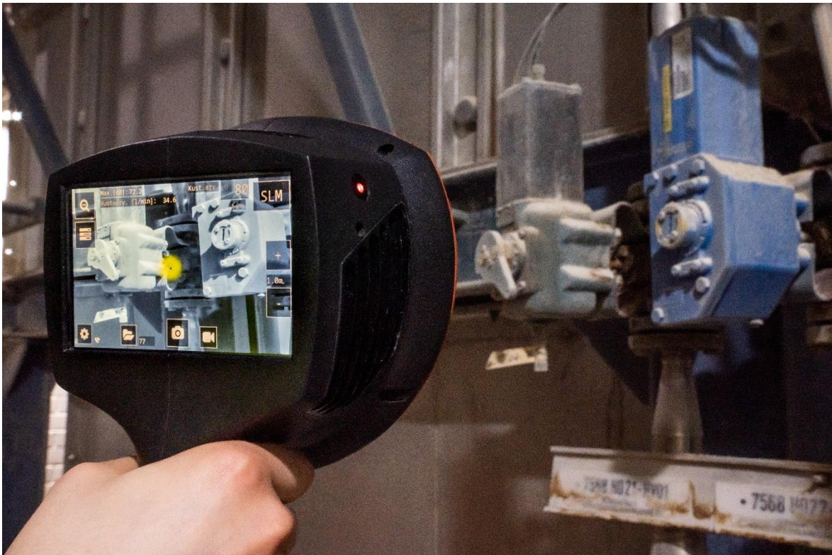
Kuva 15. Kameran havaitsema vuotava venttiili (Kuva: Santeri Leino)
