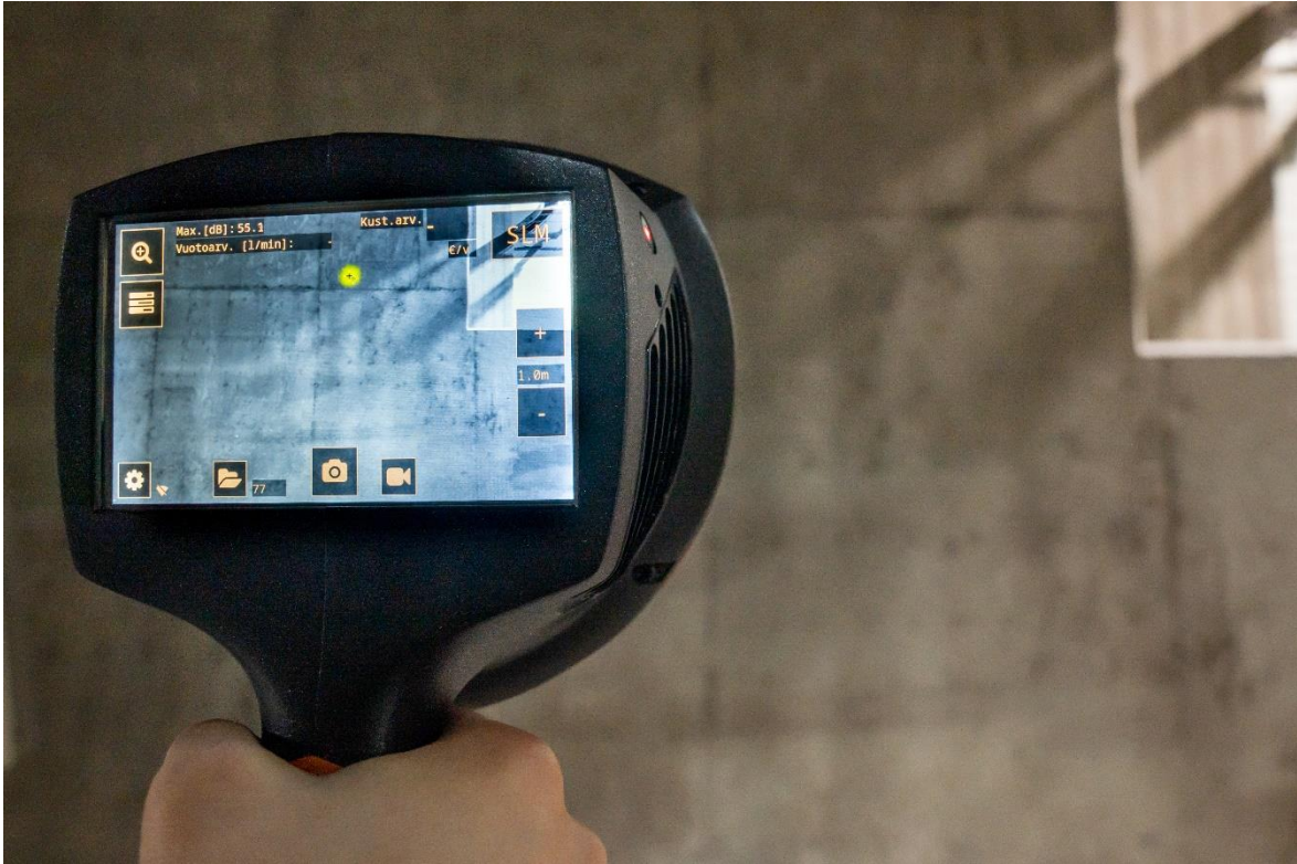
Kuva 16. Kameran näytöllä näkyy tehtaan seinästä tuleva haamuvuoto (Kuva: Santeri Leino)
