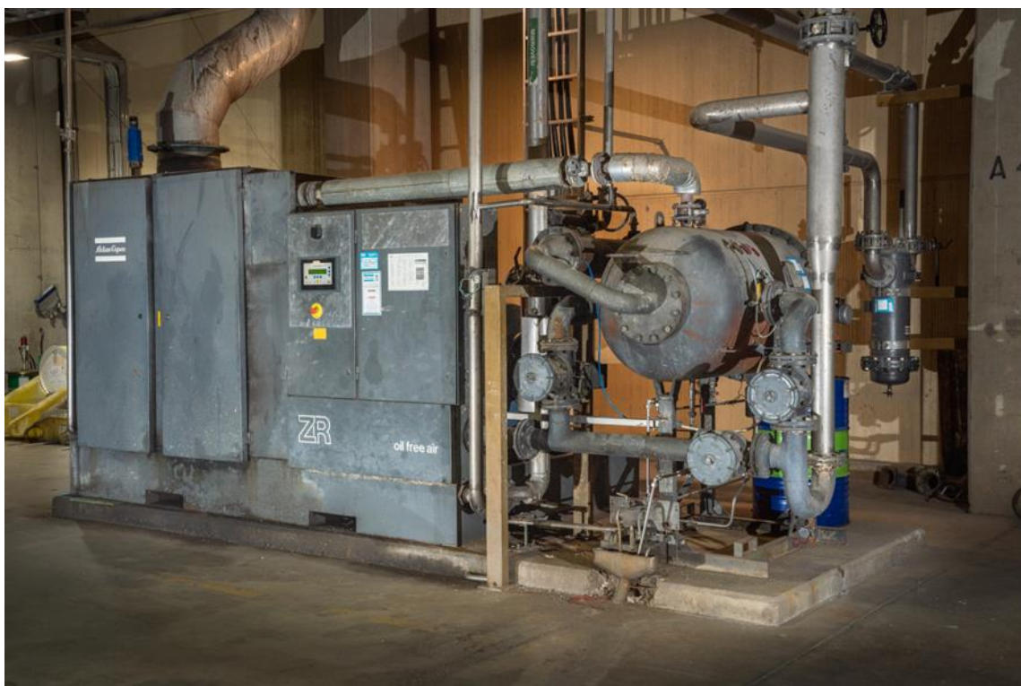
Kuva 6. Paineilmakompressori 2, jäähdytin ja suodatin (Kuva: Santeri Leino)
