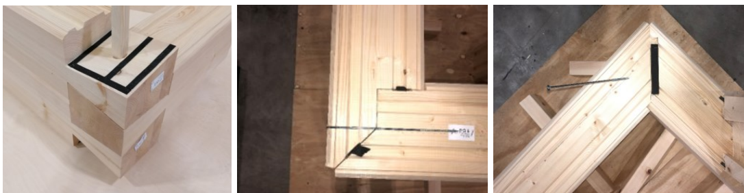
Kuva 4 Vasemmalta oikealle: Tirolinurkka, Elementtinurkka, Kartiolohenpirstönurkka. (Pellopuu Oy. 2021).
