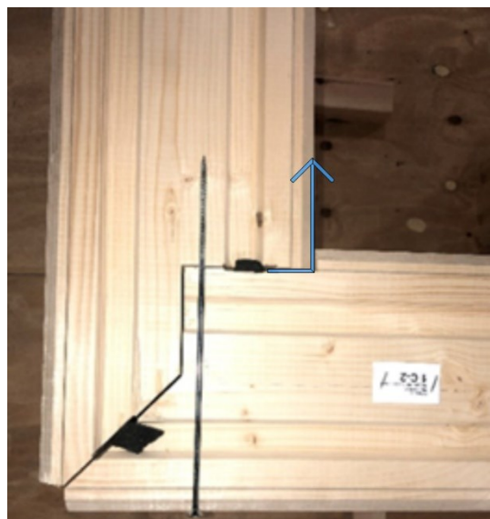
Kuva 11. Elementtinurkka (Pellopuu Oy. 2021).
